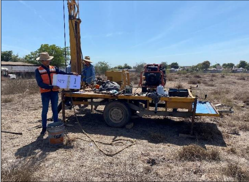
Fotografía 7. Vista de la realización del Sondeo de Penetración Estándar (SPT 1).
