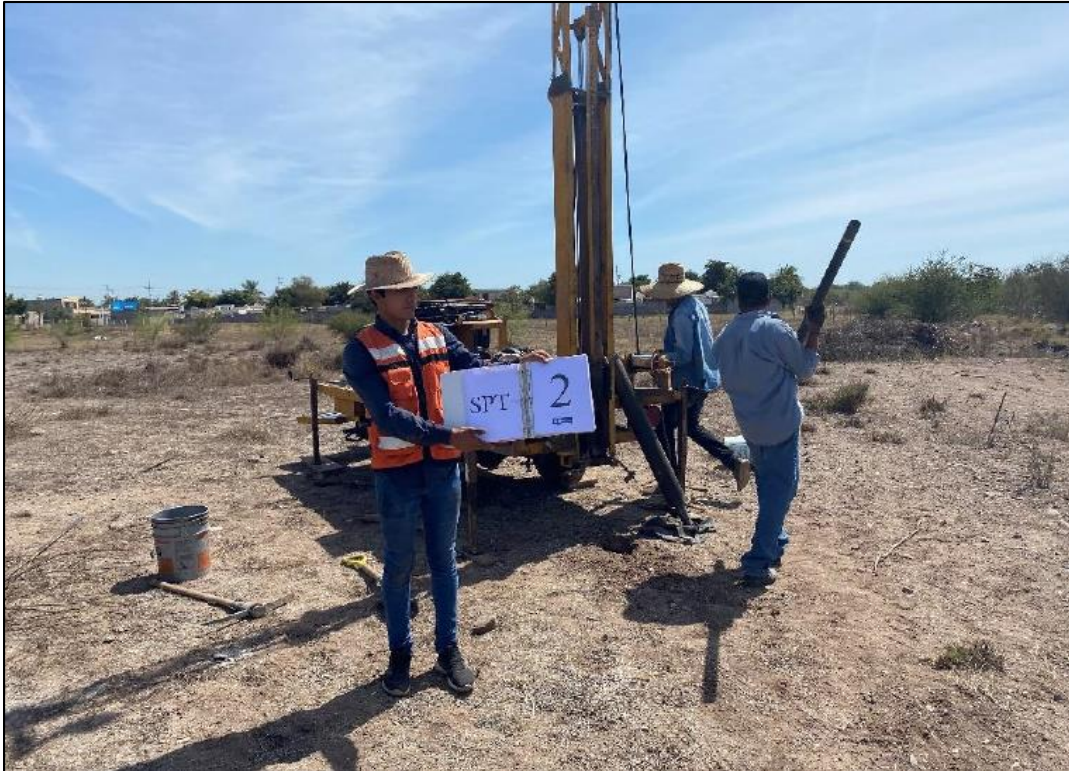
Fotografía 9. Vista de la realización del Sondeo de Penetración Estándar 2 (SPT 2).
