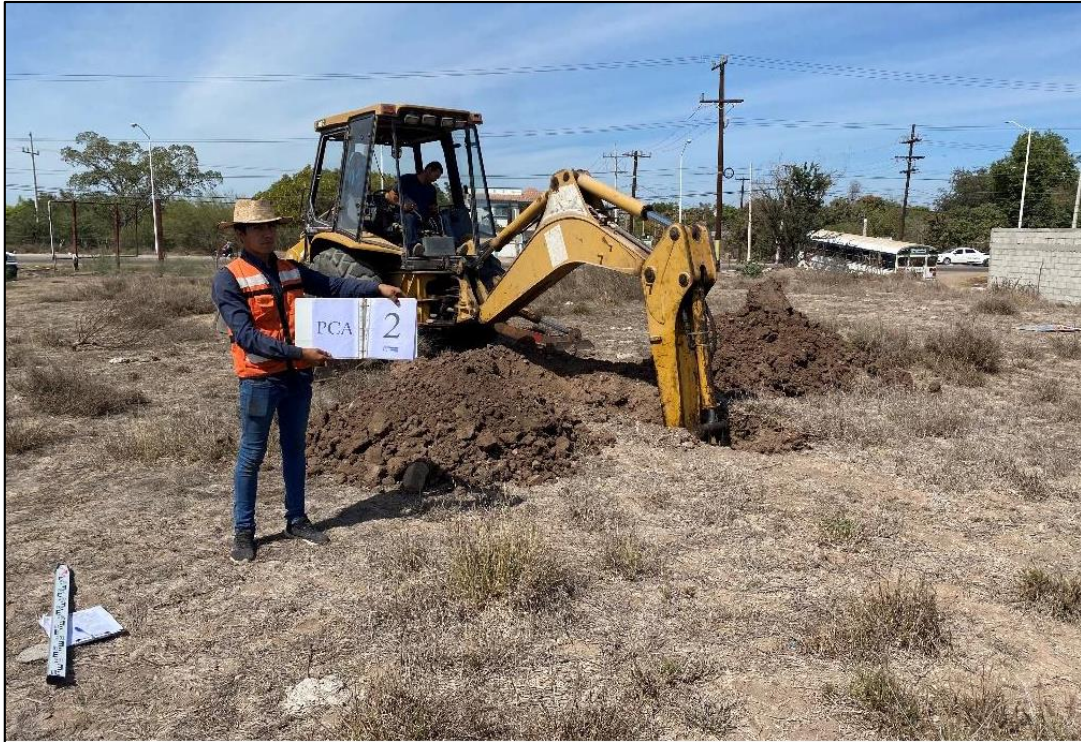
Fotografía 13. Realización del Pozo a Cielo Abierto PCA #2.
