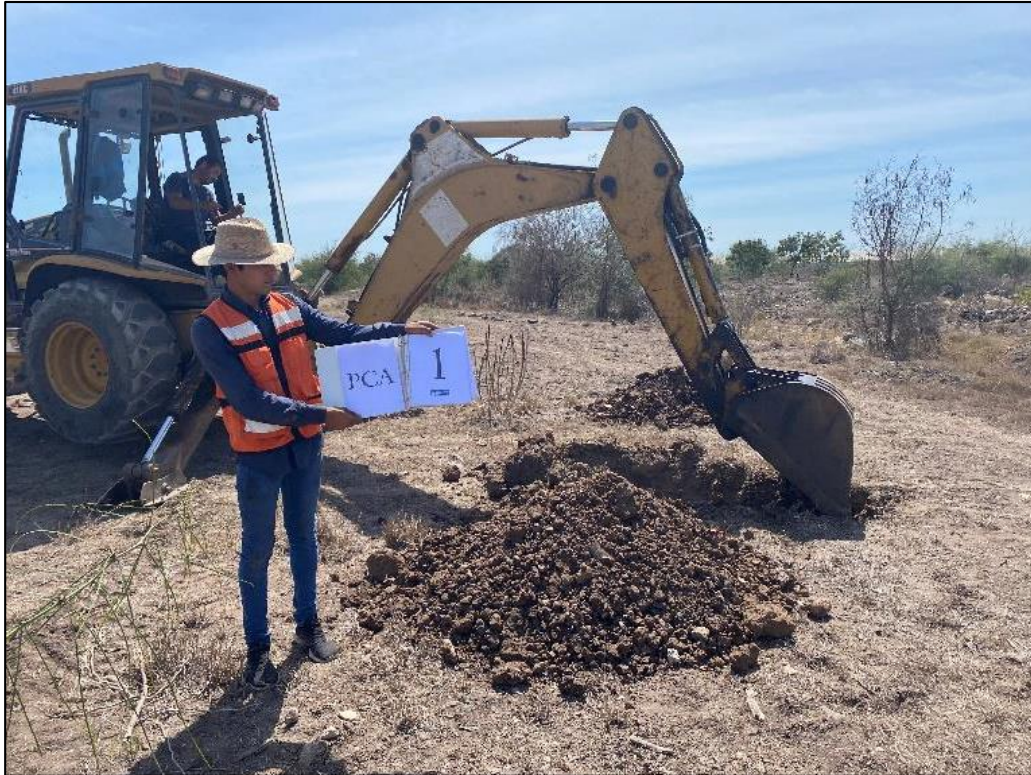
Fotografía 11. Realización del Pozo a Cielo Abierto PCA #1.
