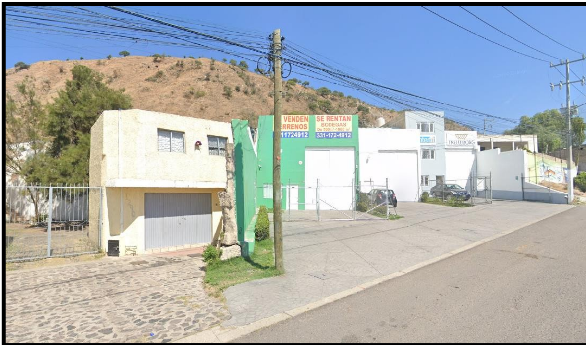
FOTOGRAFÍA 6. BODEGAS A 56.58 METROS LINEALES APROX. AL OESTE.
