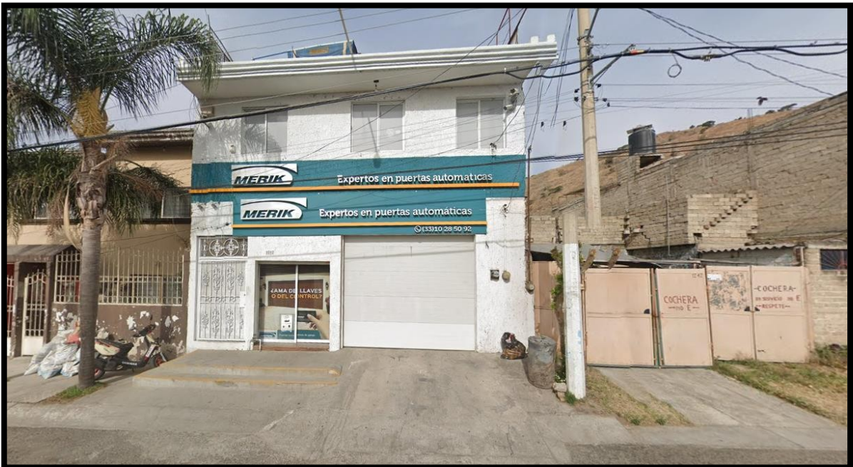
FOTOGRAFÍA 15. INSTALACIÓN DE PUERTAS Y VENTANAS A 233.80 METROS LINEALES APROX. AL SUR.
