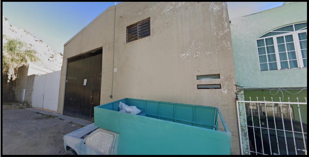
FOTOGRAFÍA 14. ALMACÉN A 230.88 METROS LINEALES APROX. AL NOROESTE.
