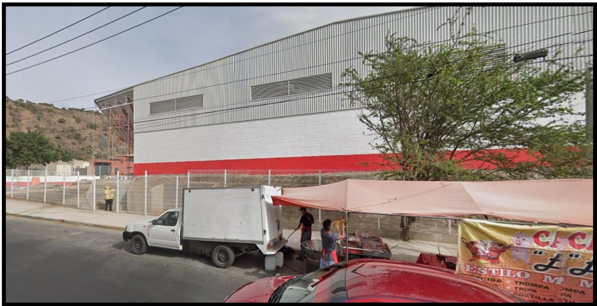
FOTOGRAFÍA 10. SERVICIO DE MENSAJERÍA "TRESGUERRAS" A 210.14 METROS LINEALES APROX. AL ESTE.
