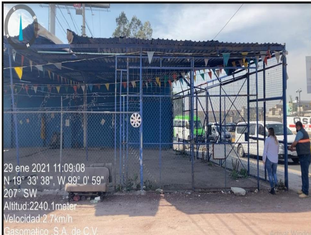
Ilustración 17 Predio donde se realizará el proyecto
