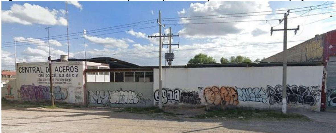
Figura III.2. Fachada del inmueble que será aprovechado para la instalación del proyecto
