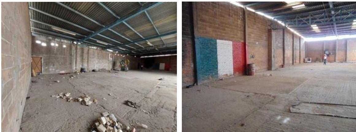
Figura III.9. Evidencia fotográfica de la ausencia de vegetación dentro del polígono del proyecto debido a la cubierta de concreto.
