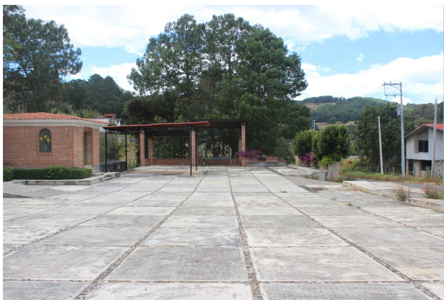
Imagen 5. Área de circulación que será retirada.
