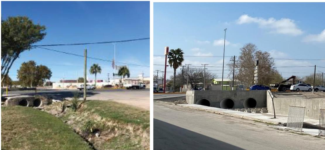
**Figura III.16.** Vista de la infraestructura para la conducción del Arroyo Primavera. a) Antes de las obras de ampliación y b) con las obras de ampliación realizadas por el municipio de Piedras Negras.
