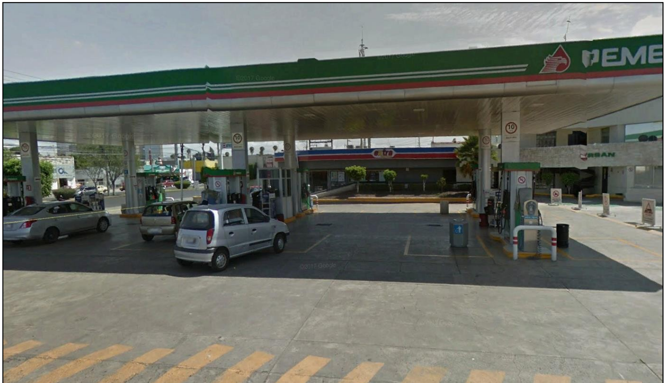
Imagen 1. Vista de la estación de servicio.
