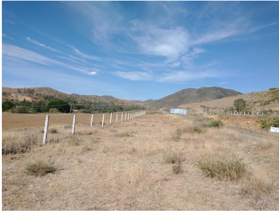
Imagen 11. Colindancia este del predio, delimitado del derecho de vía con postes y alambre de púas.
