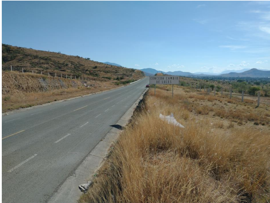
Imagen 3. Imagen de la colindancia en la parte sur, con el libramiento de Ocotlán que servirá de acceso.
