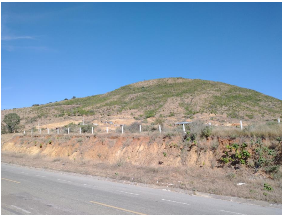
Imagen 19. Vista de la colindancia este, no se observa vegetación abundante en las colindancias.
