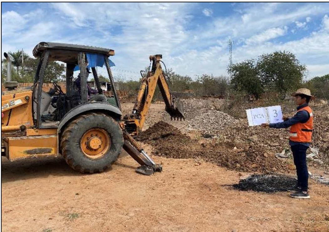
Fotografía 18. Realización del Pozo a Cielo Abierto PCA #3.
