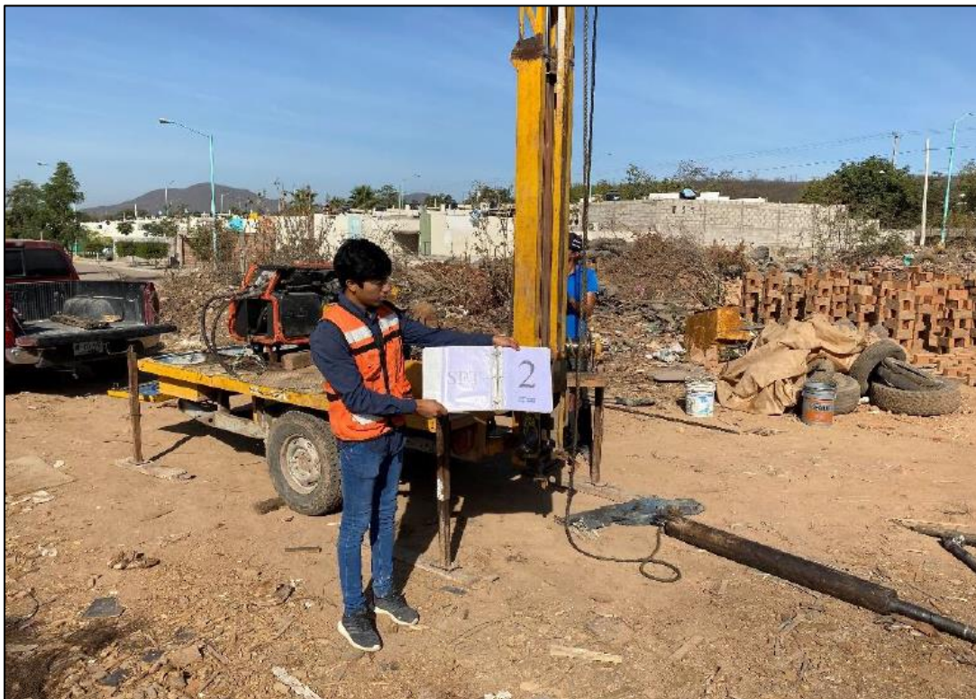
Fotografía 10. Vista de la realización del Sondeo de Penetración Estándar 2 (SPT 2).
