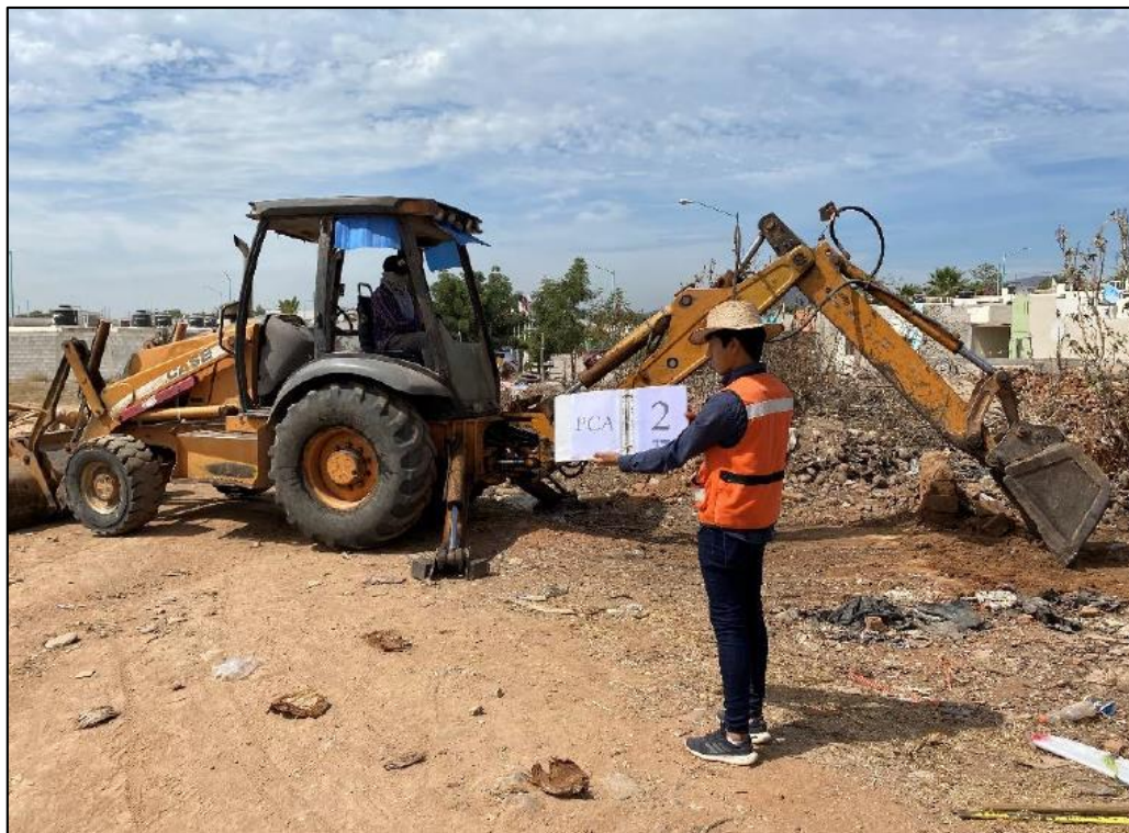
Fotografía 15. Realización del Pozo a Cielo Abierto PCA #2.
