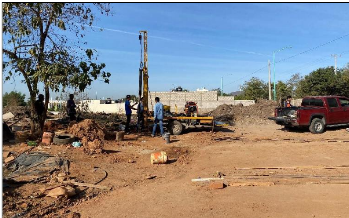
Fotografía 8. Vista de la realización del Sondeo de Penetración Estándar (SPT 1).
