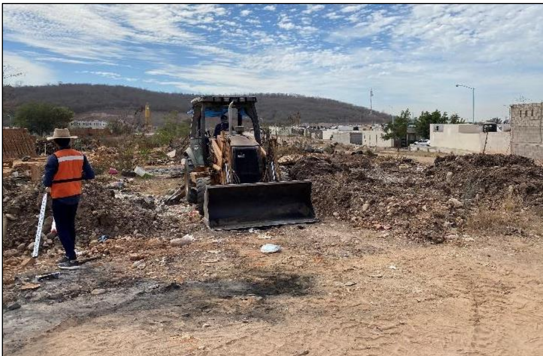
Fotografía 12. Realización del Pozo a Cielo Abierto PCA #1.
