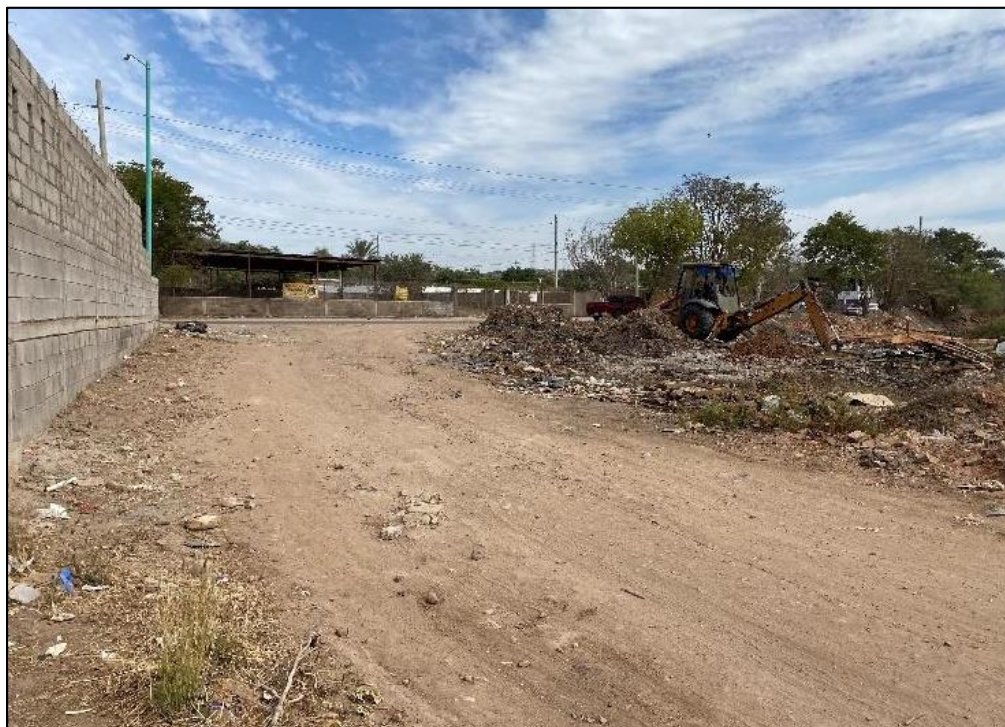
Fotografía 1. Vista panorámica del polígono del proyecto.
