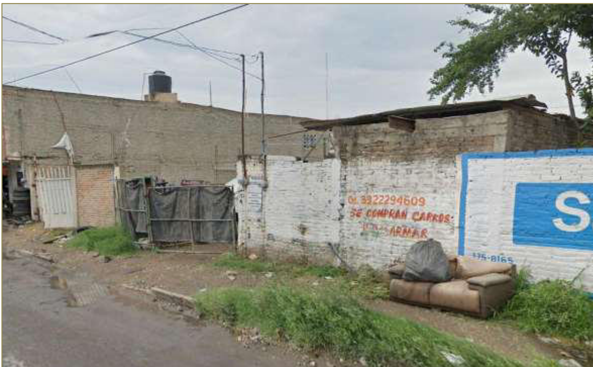
Foto III.1.a)-2. Vista desde la Prolongación Medrano, hacia la colindancia Este, en donde se aprecia una finca sin actividad.
