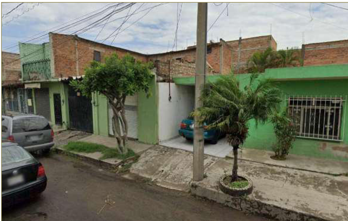
Foto III.4.d)-A)1. Tipo de vegetación inducida sobre banquetas.
