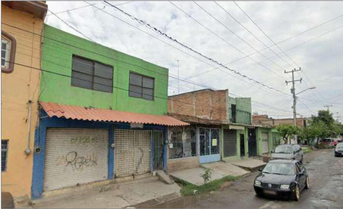
Foto III.1.a)-4 Vista desde la Prolongación Medrano, hacia el lado Norte, en donde se aprecia el cuerpo de la vialidad y casas habitación ubicadas al frente del sitio.
