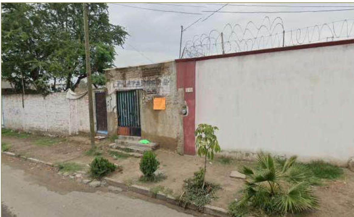
Foto III.1.a)-3. Vista desde la Prolongación Medrano, hacia la colindancia Oeste, en donde se aprecian unas fincas.
