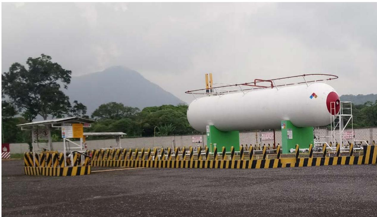
Foto 9 Tanque de Almacenamiento, con muretes de protección, toma de suministro.
