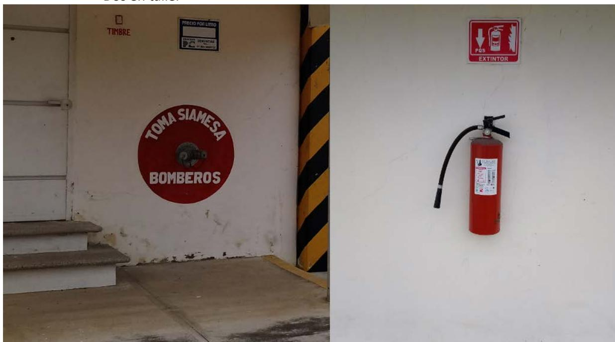
Foto 15 Arreglo de hidrantes y extintores presentes en la Planta de Distribución.
