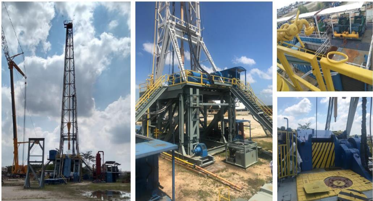
Imagen 17.- Equipo propuesto para realizar la Reparación del pozo Mayacaste 1
