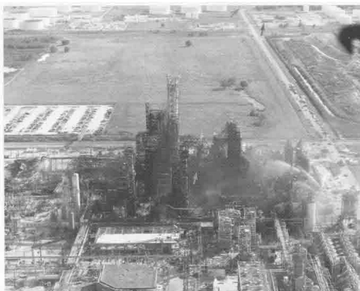
El reporte de seguridad concluyó que la alta velocidad del diésel en la tubería de llenado del tanque y la turbulencia creada resultó en la generación de un incremento de la carga estática. En este incidente se perdieron cerca de 80000 barriles de diésel.
