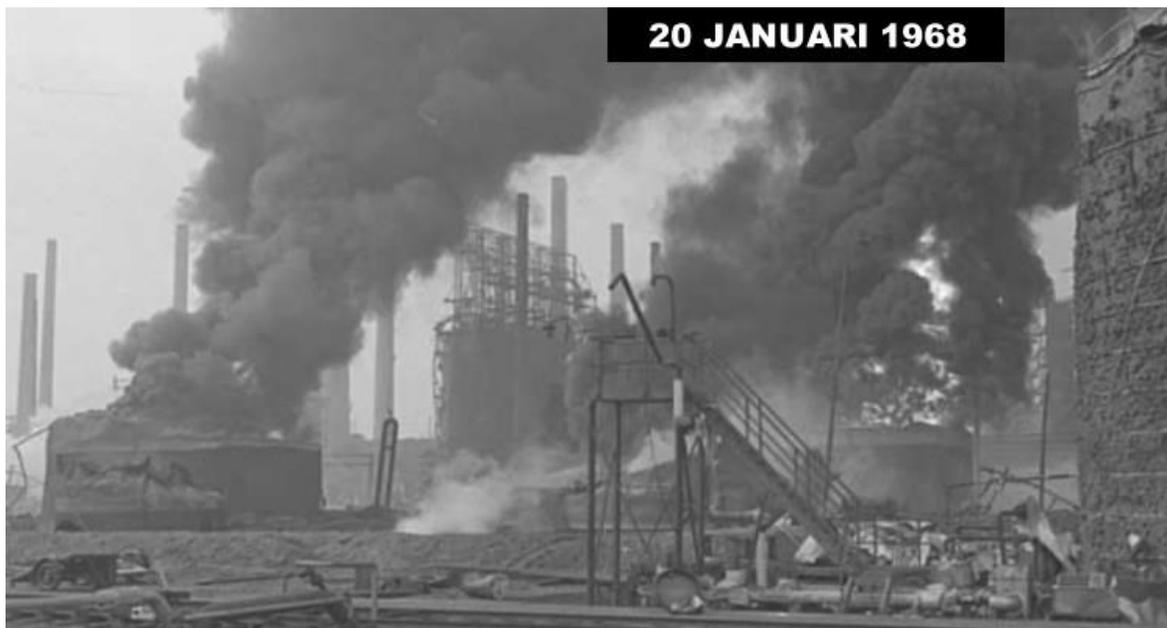
Esta emulsión fue calentada y una masiva ebullición ocurrió. Los hidrocarburos ligeros fueron liberados a través de venteos del tanque resultando en el sobrellenado de dos fases. Aunque la fuente de ignición es desconocida, el daño causado por la explosión fue extenso.
