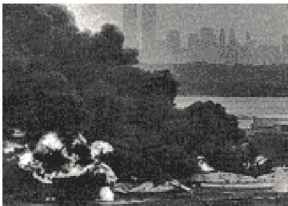
Una nube de vapor se formó como resultado de la evaporación de los componentes ligeros de la gasolina, los cuales entraron en ignición probablemente por un incinerador cercano. Hubo algunas explosiones iniciales menores seguidas de una gran explosión con una llama grande de fuego que duro quemándose 48 horas.
