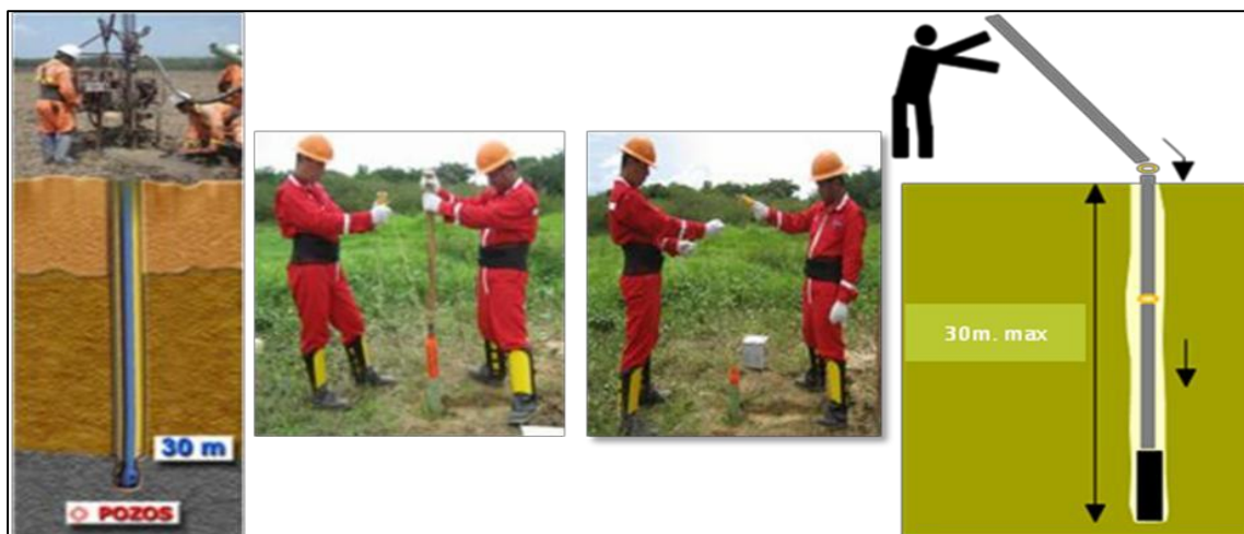
Figura 17. Cargado de Puntos de tiro con material detonante sismográficos.
