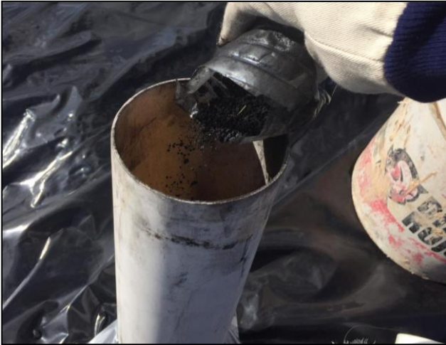
7. Preparación de los filtros de carbón activado.
