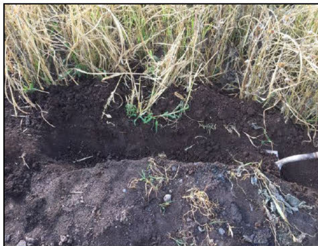
2. Utilizando herramientas manuales como palas, se procedió a la construcción de una zanja.
