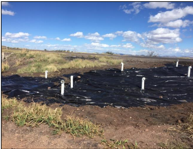
9. Colocación de filtros de carbón activado para captación de vapores.
