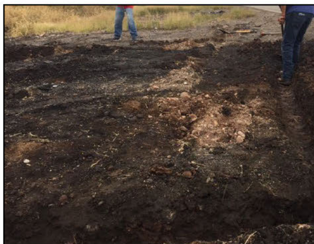
4. Toda el área afectada fue sometida a labores de emergencia, realizando zanja perimetral para la barrera de contención.
