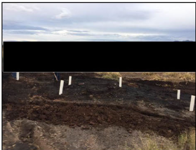
5. Seguidamente se procedió a ubicar la colocación de los filtros de carbón activado.
