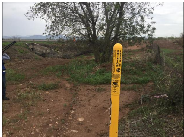
9. En el sitio de derrame hay postería que indica la presencia de fibra óptica de TELMEX, misma que no fue afectada por el derrame.
