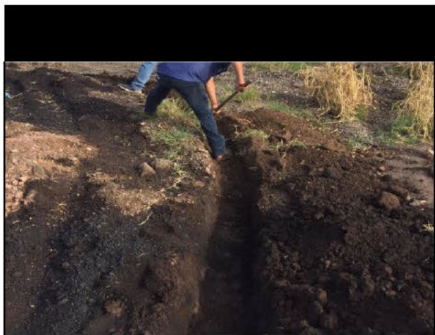
3. Personal de campo, equipado con palas y picos, procedió a realizar una zanja en los perímetros del área afectada.
