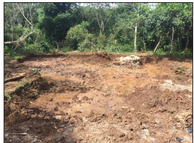
18. Vista general de la Fosa de Excavación.
