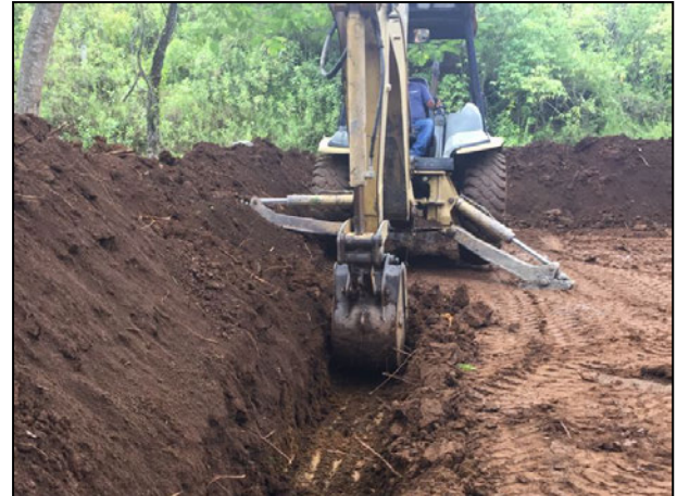
04. Construcción de canaletas de captación de lixiviados.
