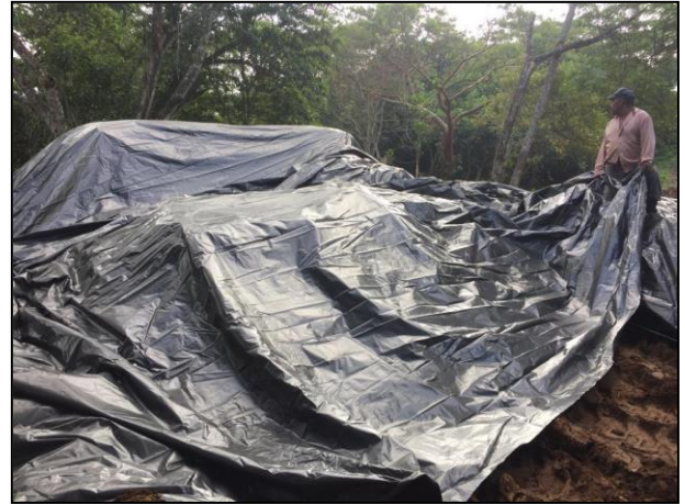
14. El material edáfico afectado colocado en celda provisional se mantuvo cubierto con membrana de polietileno de alta densidad durante las Labores de Extracción.
