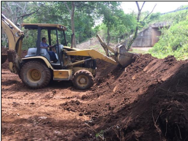
03. Se realizó la compactación de bordos perimetrales con apoyo de retroexcavadora.
