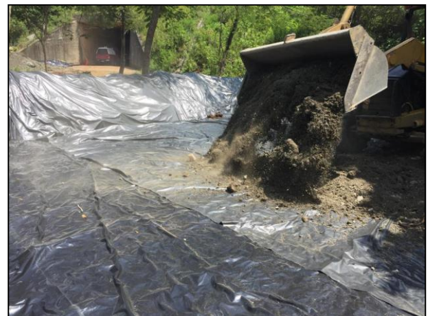
06. Posteriormente se colocó una capa de arcilla sobre la base de la celda provisional a fin de aumentar la impermeabilidad de la misma.
