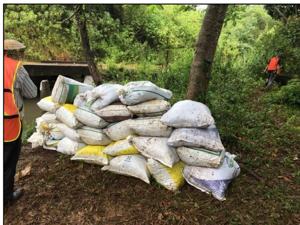
11. Costales utilizados en barrera de contención.
