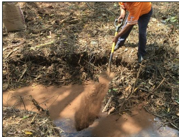
02. Con apoyo de equipo manual se realizó la aplicación del musgo absorbente.
