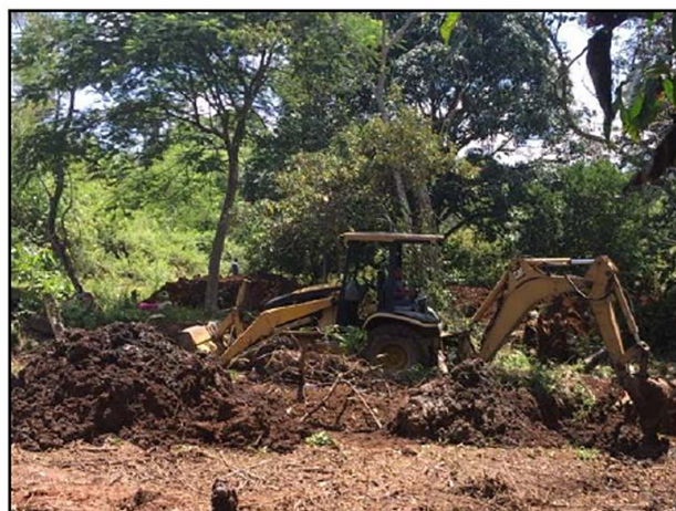
10. Con apoyo de retroexcavadora se realizó la extracción del material edáfico afectado con Gasolina.
