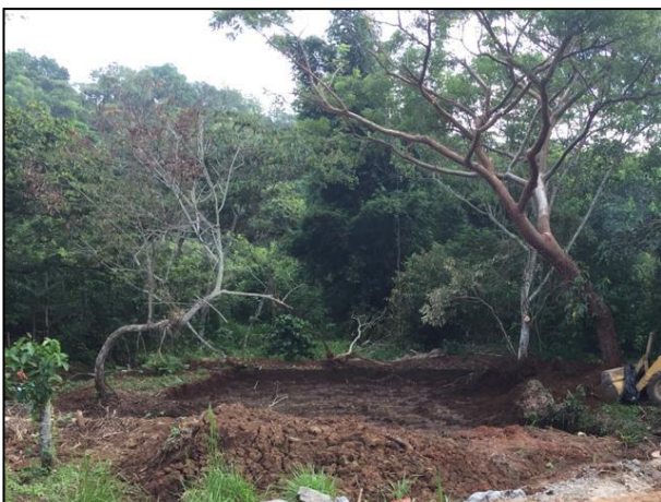
17. Área sometida a Labores de Extracción.
