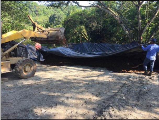
13. Se colocó el material edáfico afectado en la celda provisional cuidando la emisión de gases a la atmosfera.
