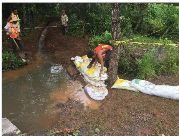
12. Se colocó una barrera de contención esto con el objetivo de que el agua no estuviera en contacto con el suelo afectado con Gasolina.
