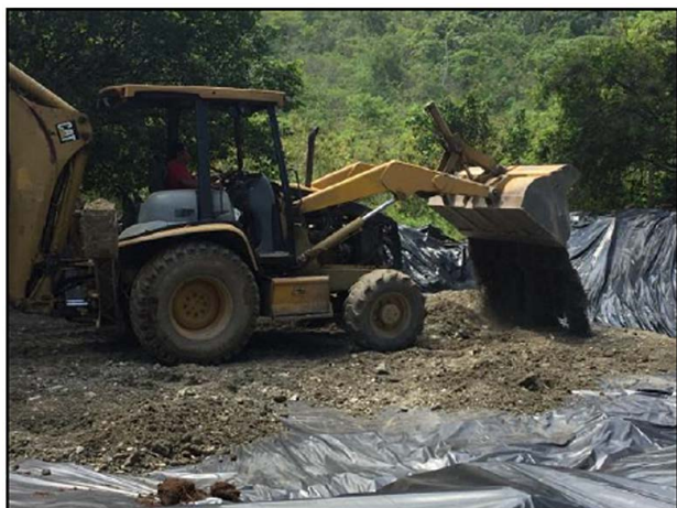
07. Esparcimiento de capa de arcilla.
