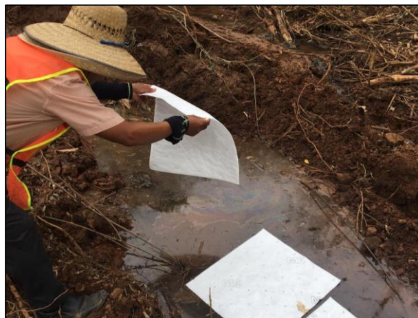
06. Se colocaron tapetes oleofílicos e hidrofóbicos a fin de absorber el hidrocarburo suspendido en el agua.
