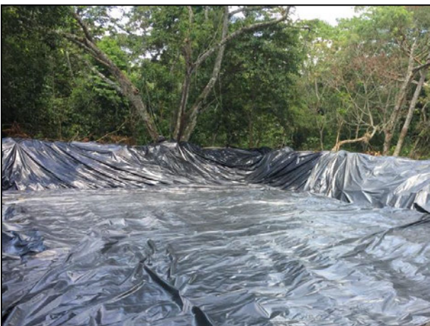
05. Se colocó una membrana de polietileno de alta densidad en la base de la celda provisional.
