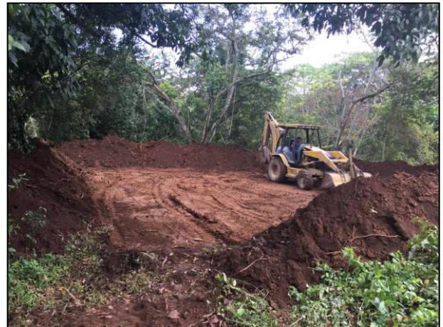
02. Construcción de bordos perimetrales para la celda provisional.
