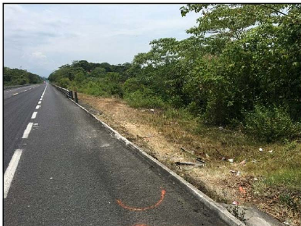
01. Km. 183 + 400 de la Carretera 132-D Tulancingo – Tihuatlán, tramo Ávila Camacho – Cañada Rica, municipio de Jalpan, estado de Puebla.
