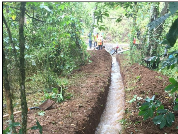
10. Vista del desvío realizado en el cauce del arroyo intermitente innominado de captación pluvial.
