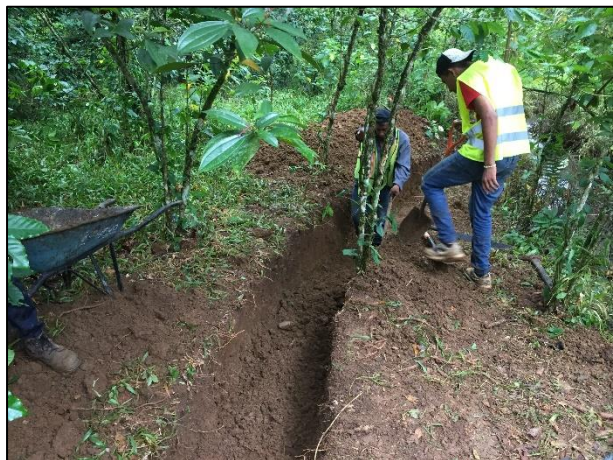
09. Se realizó el desvío del mencionado cauce a fin de evitar una mayor afectación en el mismo.
