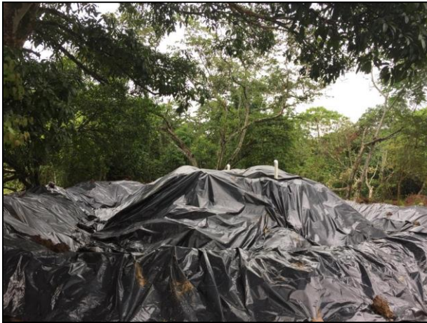
15. La celda provisional fue cubierta en su totalidad con membrana de polietileno de alta densidad.
