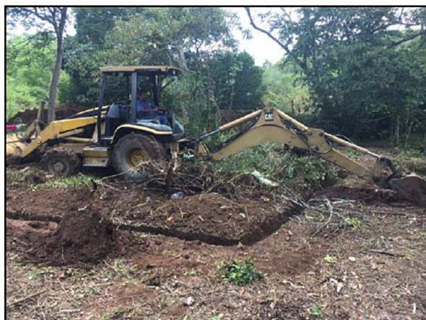
09. Extracción a detalle de material afectado con apoyo de maquinaria pesada.
