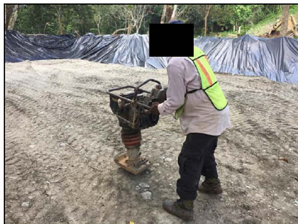
08. Con apoyo de bailarina compactadora se realizó la compactación de la capa de arcilla.
