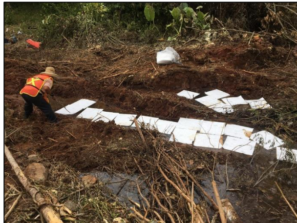
08. Colocación de tapetes olefilicos e hidrofóbicos.
