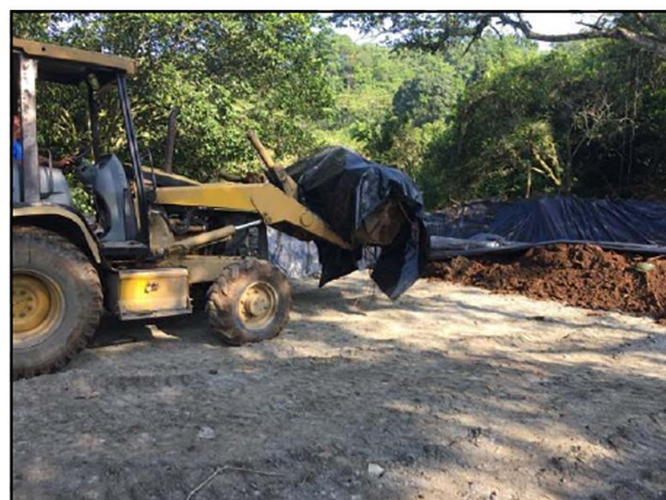
12. Acarreo de material edáfico afectado hacia celda provisional.
