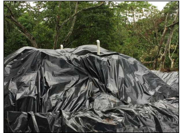
16. Se colocaron filtros de carbón activado a fin de evitar la emisión de Compuestos Orgánicos Volátiles (COV's) hacia la atmosfera.
