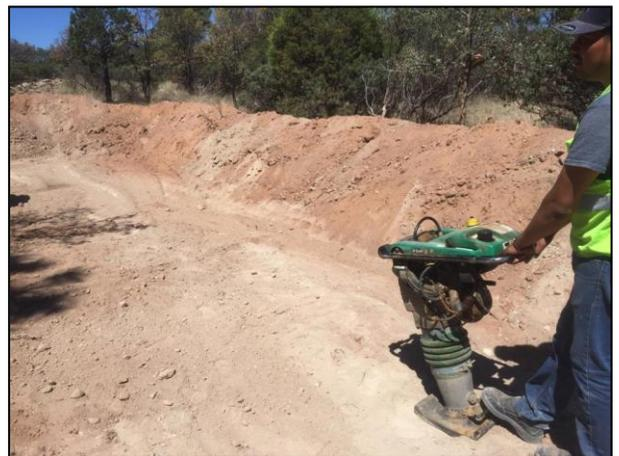
6. Compactación de la capa de arcilla, utilizando un v bro compactador manual.
