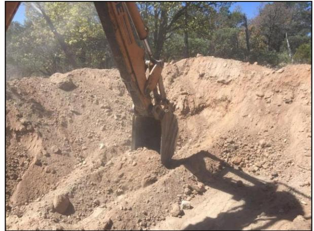
4. Construcción de canaletas para la captación de lixiviados.
