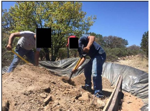
16. Con apoyo de recurso humano, se procedió a depositar el material edáfico extraído y acarreado en la celda provisional.
