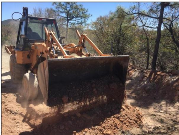
5. Con apoyo de retroexcavadora se colocó una capa de arcilla en la base de la celda provisional.
