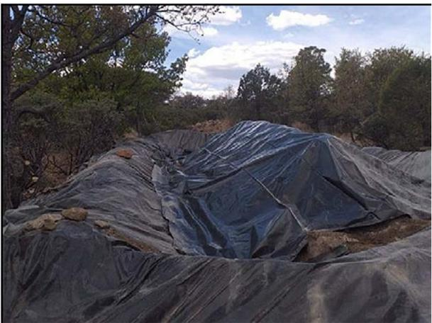
23. Celda provisional construida, donde se colocó el material edáfico extraído.
