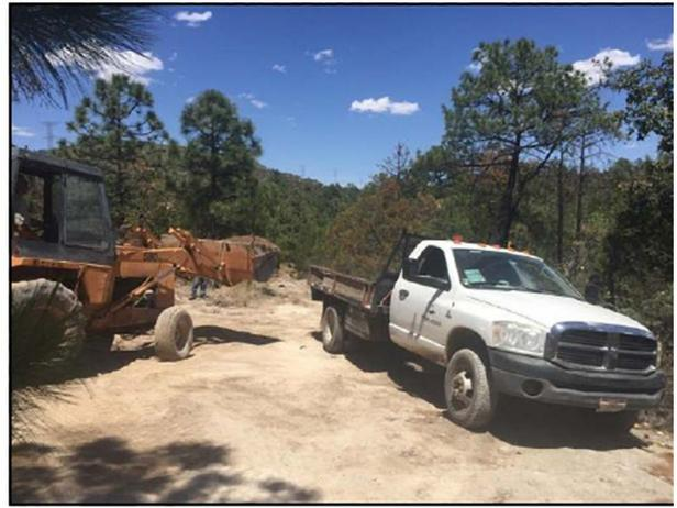
14. Con apoyo de retroexcavadora, se acarrió el material edáfico al camión, para seguidamente llevarla a la celda provisional.
