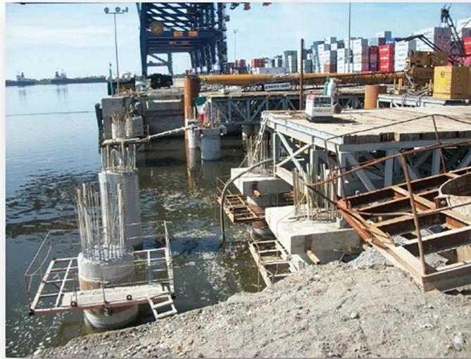
**Imagen 33. Colocación de estructura para cabezales**
