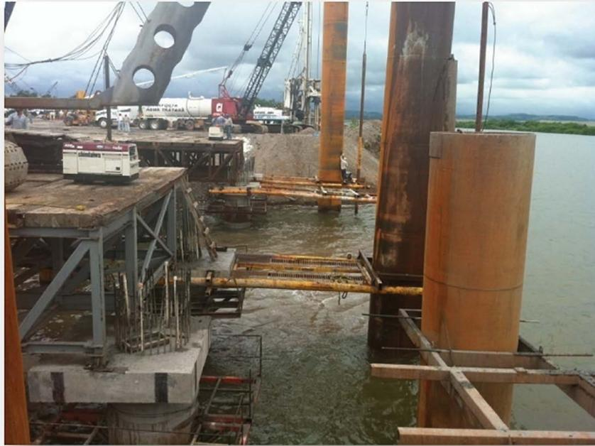
**Imagen 23. Construcción de posiciones de atraque en agua**
