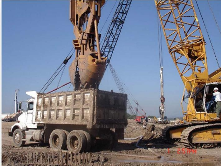
**Imagen 20. Excavación y retiro del material**
