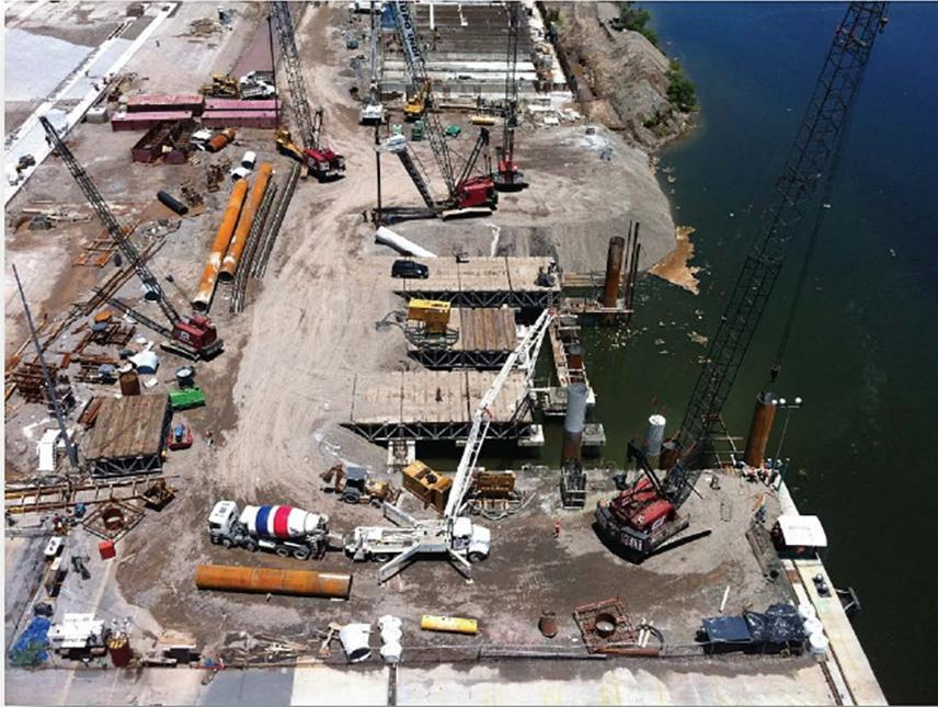
**Imagen 22. Construcción de posiciones de atraque**
