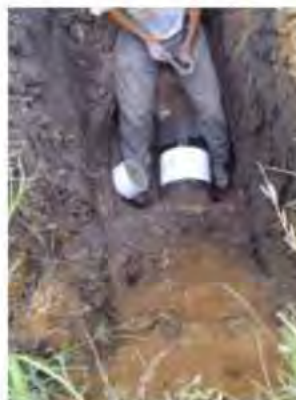
FIGURA II.7 SOLDADURA CADWELD Y REPARACIÓN DE RECUBRIMIENTO DEL TUBO
