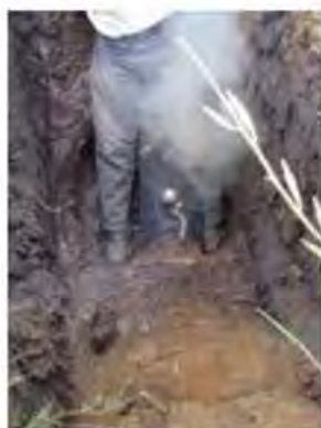
FIGURA II.7 SOLDADURA CADWELD Y REPARACIÓN DE RECUBRIMIENTO DEL TUBO
