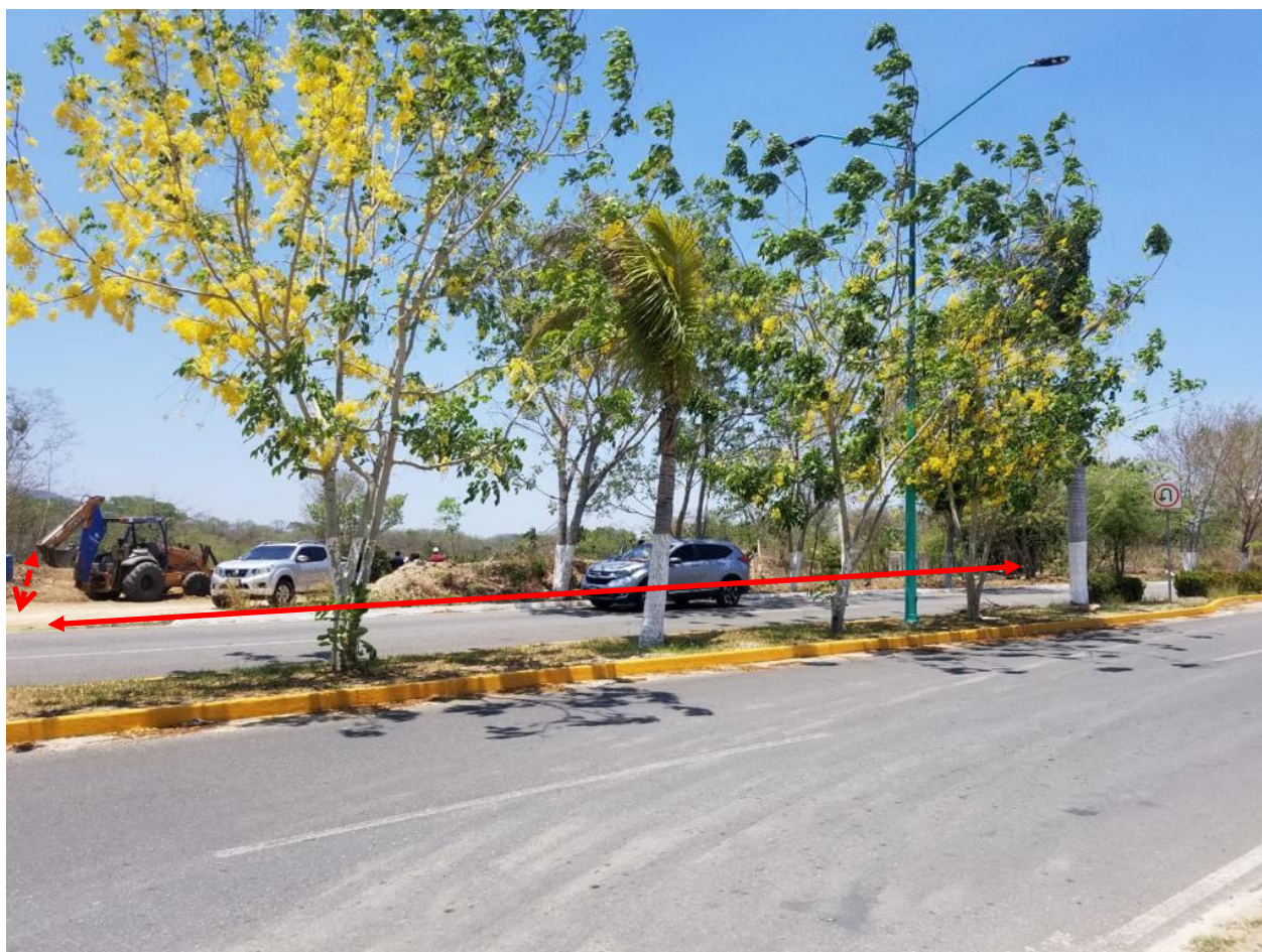
Fotografías 1.- Vista del acceso principal para la operación de la estación de servicio.
