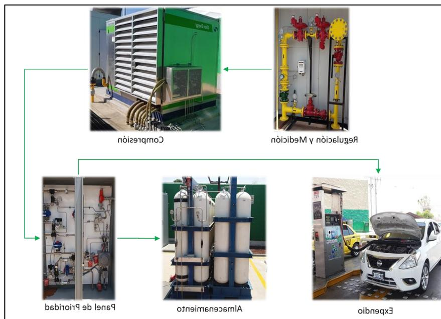
Figura II.24 Diagrama del Proceso del Gas Natural en la próxima Estación de Servicio de Gas Natural Comprimido “Estación León Norte”
