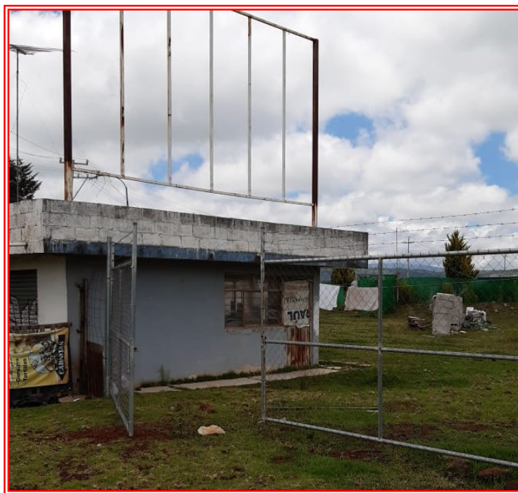
Imagen No. 5 Fotografía de la construcción ya hecha.
