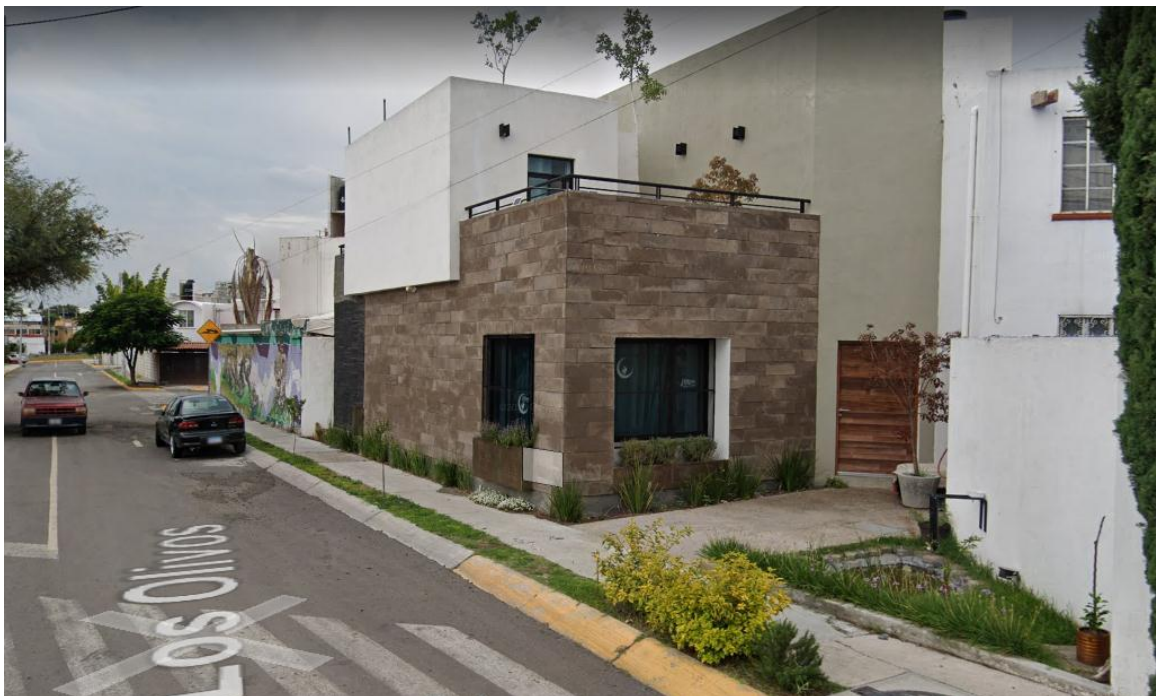
Fig. 31 Vista de las instalaciones ubicadas al sur del predio.
