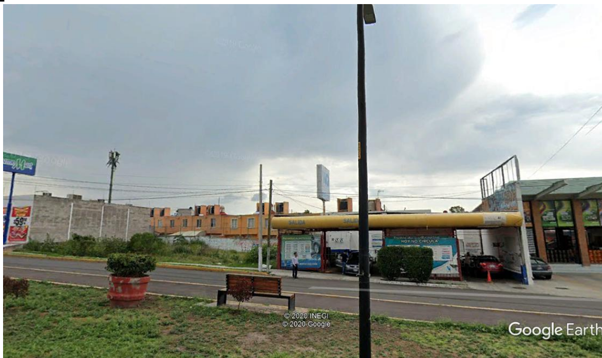
Fig.7 Comercios y casas ubicados sobre la Av. Prol. Zaragoza frente al límite oeste del predio
