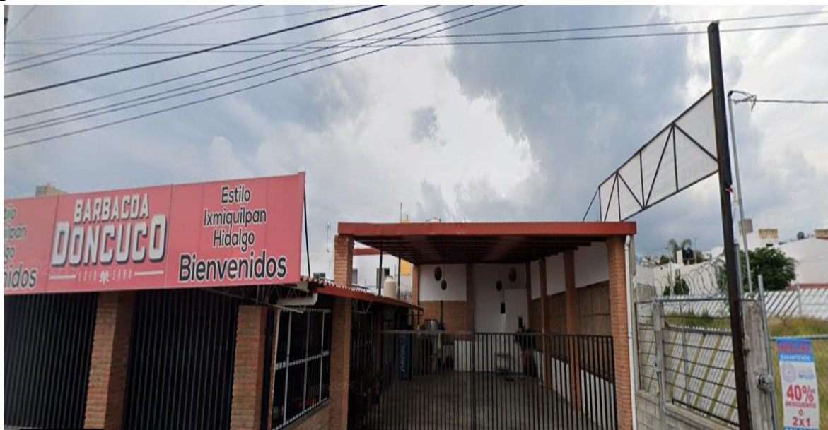
Fig. 33 Vista de las instalaciones que se encuentran al norte del predio.
