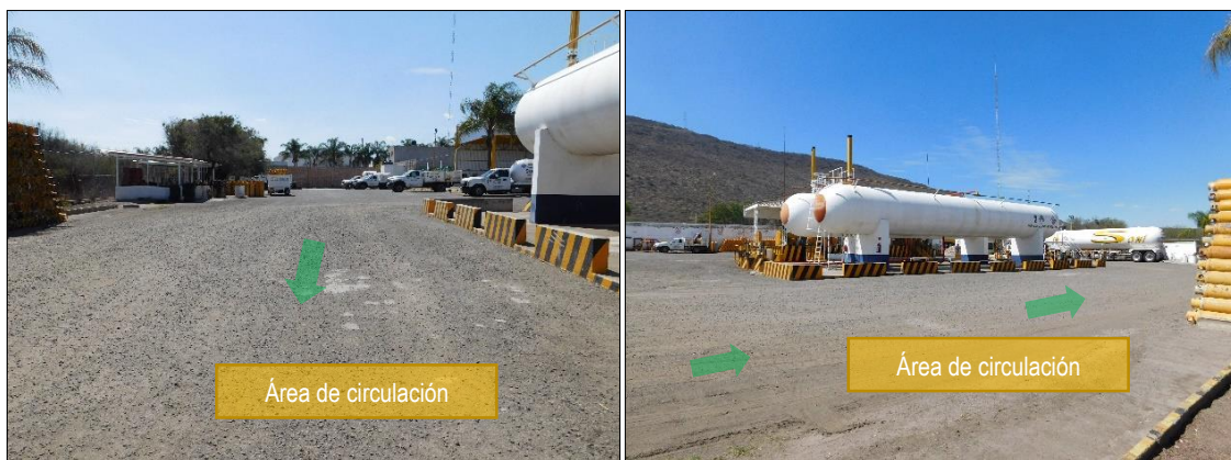
Figura IV.14. La Planta de distribución de gas I. p. (área del proyecto) se encuentra en etapa operativa, la superficie esta desprovista de vegetación y en su totalidad con suelo compactado (ver anexo fotográfico).
