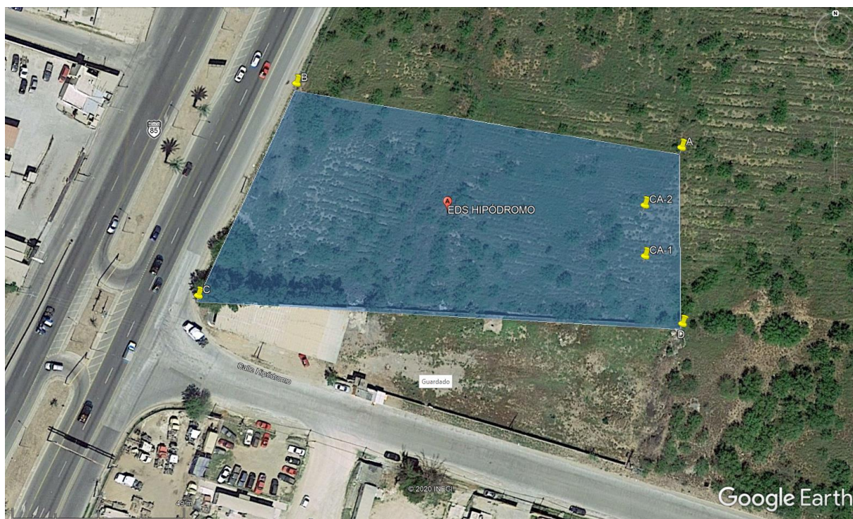
Figura II.11 Ubicación de cilindros de almacenamiento
