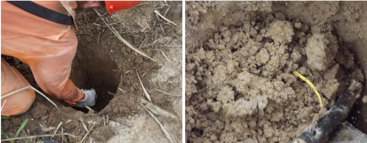
**Figura II.10.** Ejemplo de actividades de barrenado y tapado de pozos.
