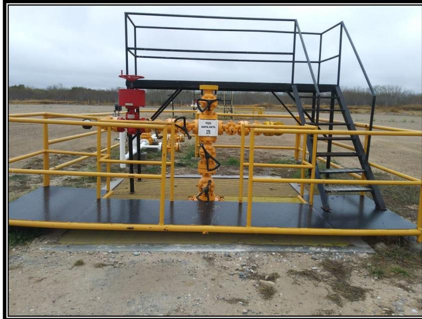
**Fotografía I.1.5-8.-** Localización construida para el Pozo Santa Anita 278.
