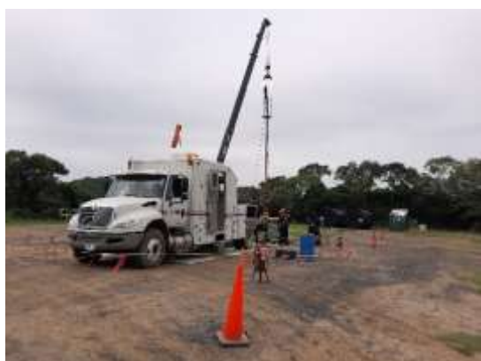
Registro Fotográfico No. 20. Actividad inducción con unidad mecánica de suabeo en pozo La Laja 11DEL.
