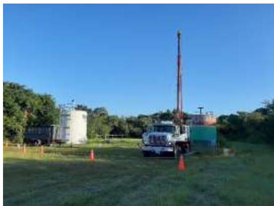
Registro Fotográfico No. 12. Actividad de inducción mecánica suabeo en Pozo La Laja 9.
