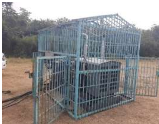
Registro Fotográfico No. 23. Instalación de unidad de bombeo mecánico en pozo La Laja 9.
