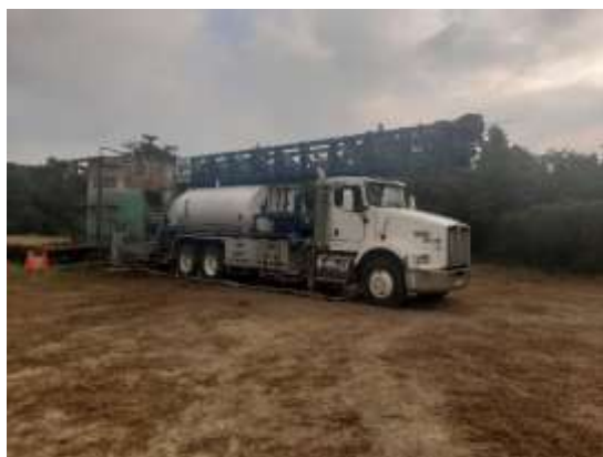
Registro Fotográfico No. 22. Actividad de introducción de aparejo de bombeo mecánico en pozo La Laja 9.
