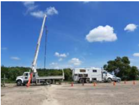
Registro Fotográfico No. 6. Actividad de calibración de Pozo La Laja 11DEL con unidad de línea de acero.
