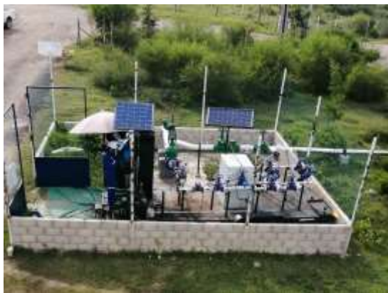
Registro Fotográfico No. 3. Bombeo y medición de hidrocarburos mediante patín de medición tipo Coriolis.
