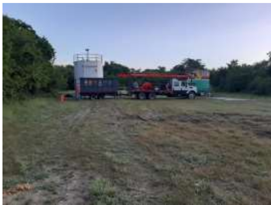
Registro Fotográfico No. 19. Actividad inducción con unidad mecánica de suabeo en pozo La Laja 9.
