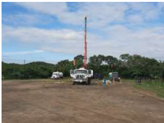
Registro Fotográfico No. 10. Actividad de inducción mecánica (suabeo) en el pozo La Laja 11DEL.
