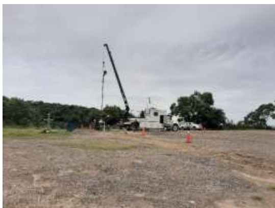
Registro Fotográfico No. 20. Actividad inducción con unidad mecánica de suabeo en pozo La Laja 11DEL.
