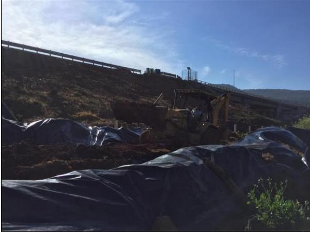
13. Depósito de material edáfico afectado en celda provisional.
