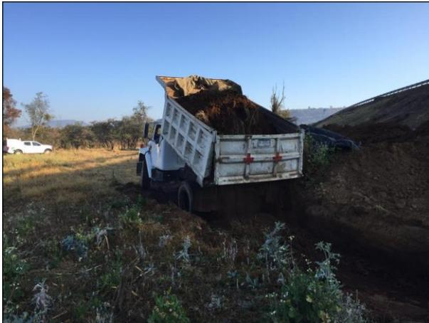
15. Depósito de material edáfico libre de contaminantes como relleno en la fosa de excavación y zona de excavación "A".
