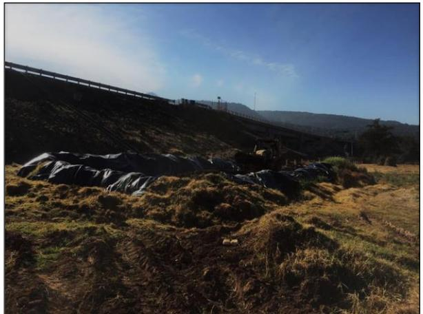
12. Depósito de material edáfico afectado en celda provisional.
