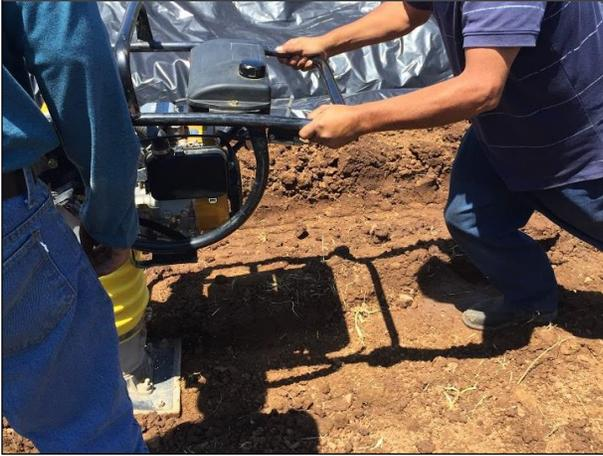
8. Con apoyo de vibro compactador manual se compactó la capa de arcilla colocada en la celda provisional.
