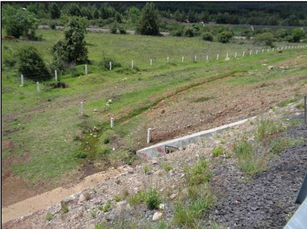
3. En el sitio se observa canaletas de concreto por las cuales el Diésel se desplazó hasta afectar material edáfico.
