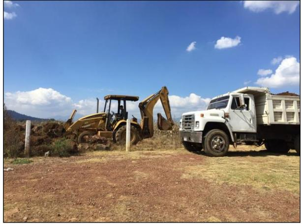
8. Extracción de material edáfico afectado por el derrame del hidrocarburo.
