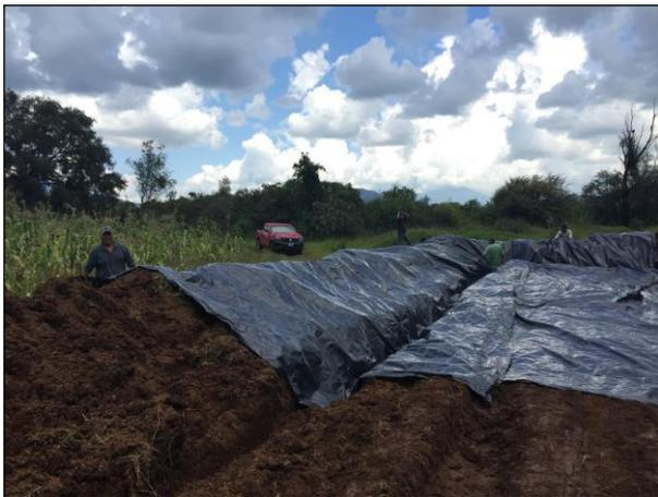
6. Se construyeron canaletas para captación de lixiviados y se cubrió la celda provisional con película de polietileno de alta densidad.
