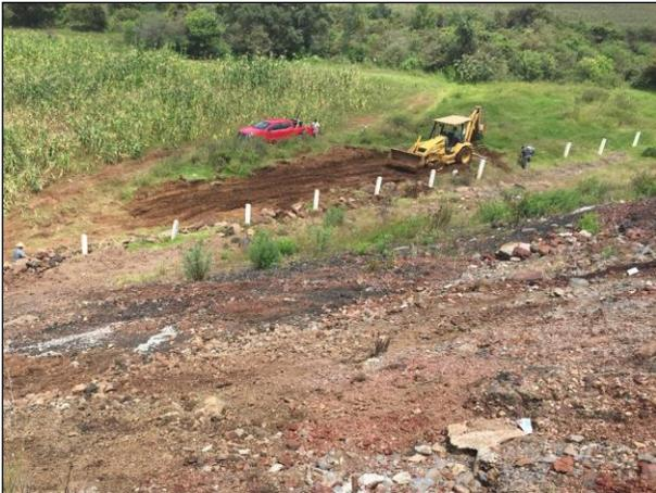
4. Nivelación del terreno donde se construyó la celda provisional, en la cual posteriormente se depósito material edáfico afectado por el hidrocarburo.
