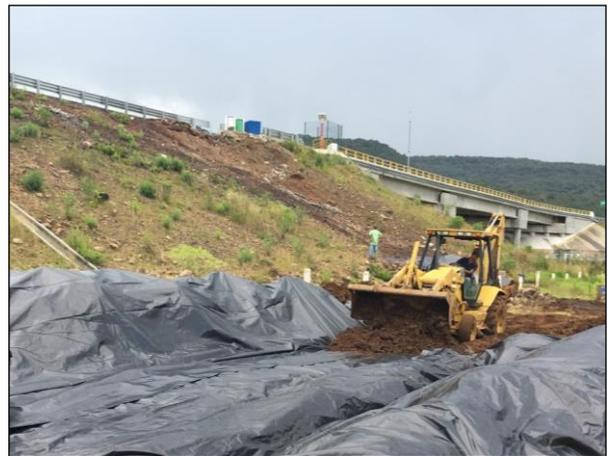
7. Con apoyo de retroexcavadora se tendió una capa de arcilla sobre la película de polietileno para aumentar la impermeabilidad de la celda provisional.
