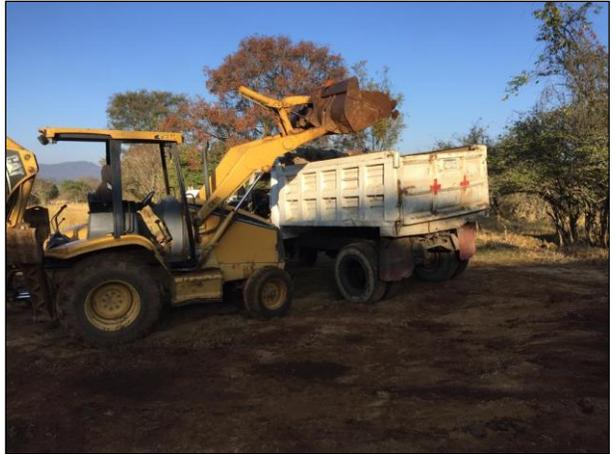
10. Depósito de material edáfico afectado en camión de volteo para su traslado y posterior depósito en celda provisional.
