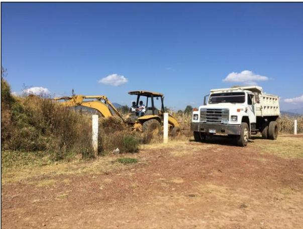
11. Acarreo de material afectado en camión de volteo para posterior depósito en celda provisional
