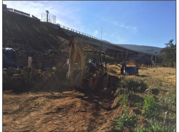
5. Construcción de los bordos de la celda provisional.
