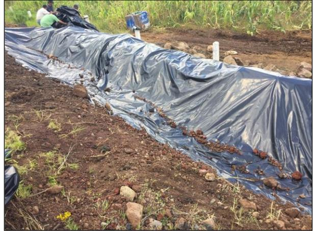
3. Se extendió una película de polietileno de alta densidad sobre la barrera de contención para aumentar la impermeabilidad de esta.
