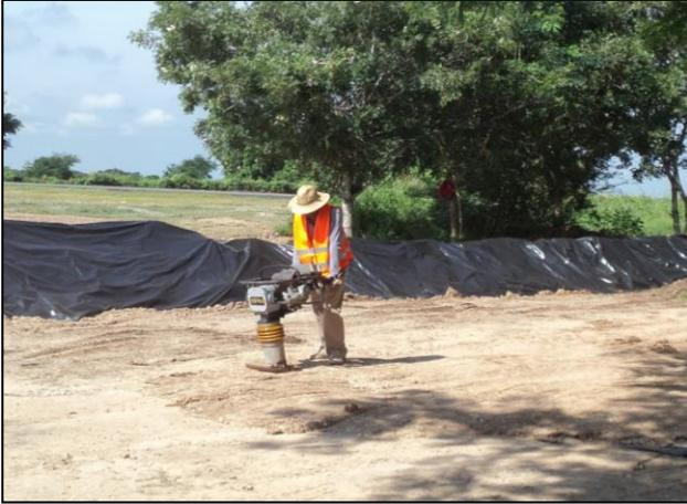
7.- Compactación de la capa de arcilla colocada en la celda provisional, con apoyo de vibro compactador manual.
