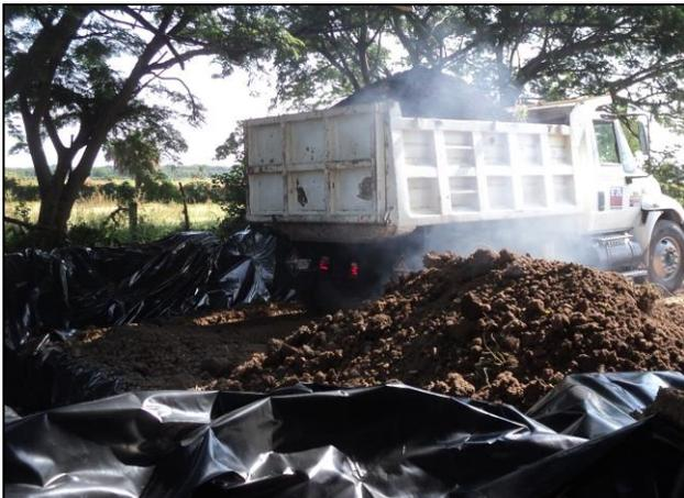
9.- Depósito de material edáfico afectado con Diésel en celda provisional.
