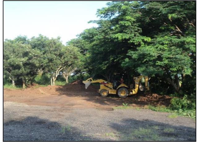
2.- Construcción de bordos de la celda provisional con ayuda de la retroexcavadora.
