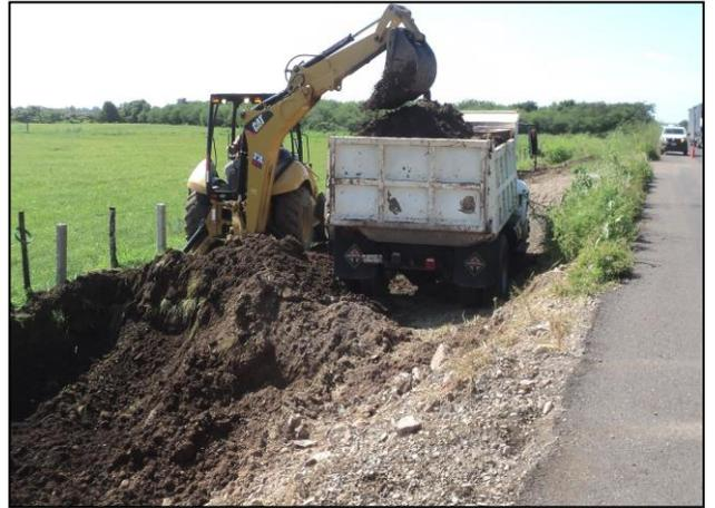
8.- Depósito de material afectado en camión de volteo para posterior depósito en celda provisional.
