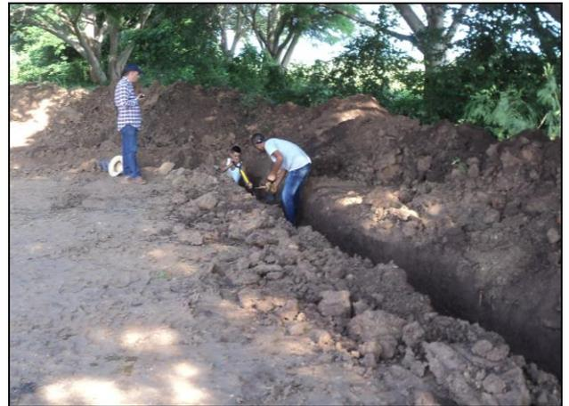
4.- Construcción de bordos y canaletas de captación de lixiviados.
