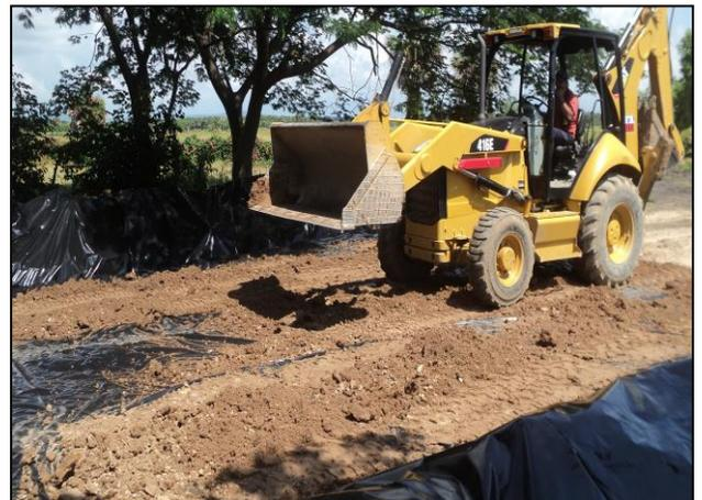
6.- Colocación de la capa de arcilla en el suelo de la celda provisional.
