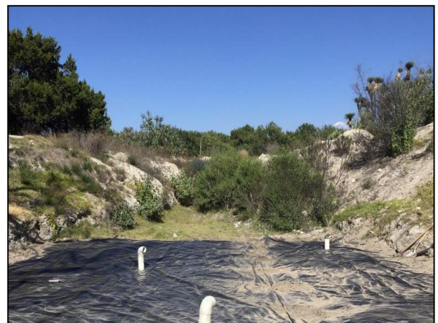
6.- Área afectada cubierta con película de polietileno de alta densidad con filtros de carbón activado.
