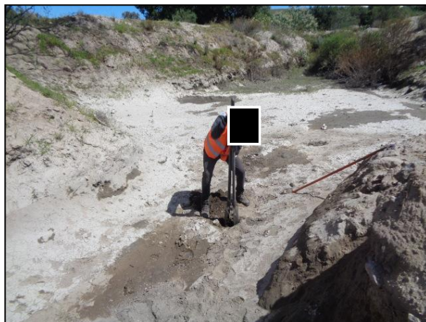
5.- Suelo natural afectado por el derrame de Gasolina.
