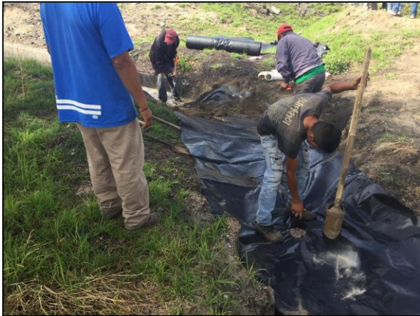
1.- Se colocó película de polietileno de alta densidad en el área afectada.
