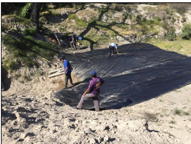
5.- La barrera de contención se construyó con material edáfico de la zona (libre de contaminantes).
