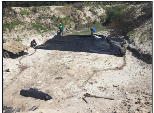
4.- El área afectada se cubrió con película de polietileno de alta densidad.
