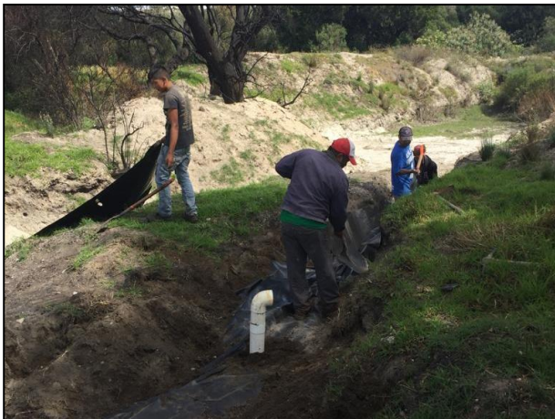
3.- Colocación de filtros de carbón activado en el área afectada.
