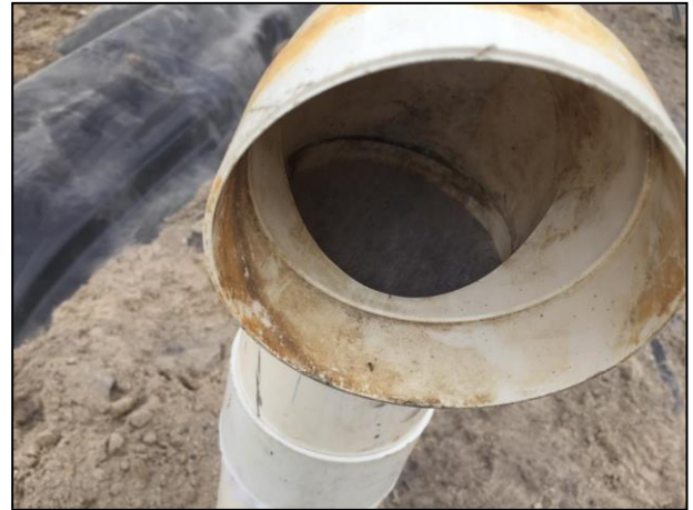
2.- Se colocaron filtros de carbón activado para evitar la transferencia de contaminantes a la atmósfera.
