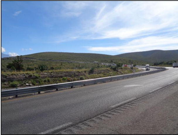
1.- Sitio del accidente ocurrido en el Km. 206 + 900 de la Autopista Puebla – Córdoba, municipio de Esperanza, estado Puebla.
