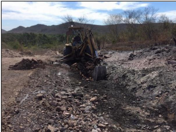
9.- Extracción de material afectado con apoyo de retroexcavadora.
