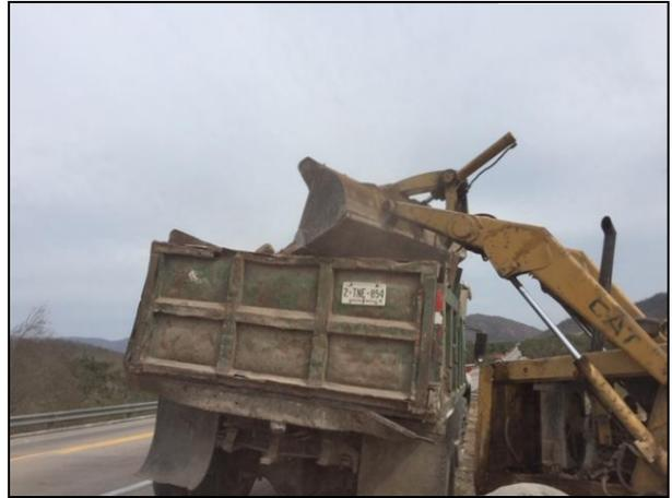
10.- Con la retroexcavadora se colocó el material afectado a camión de volteo.
