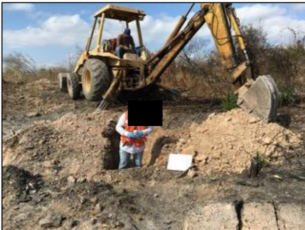
5 – Debido a la naturaleza del sitio se requirió el apoyo de una retroexcavadora para llegar a las profundidades deseadas en la periferia de la fosa de excavación.
