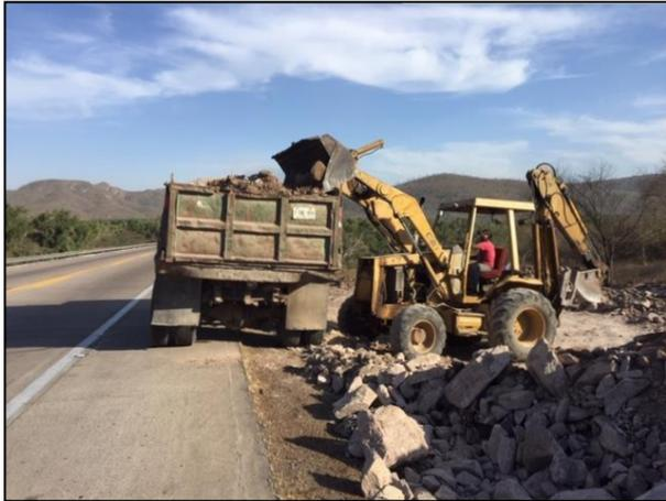
7.- El material extraído fue colocado en un camión de volteo para trasladarlo a la celda provisional.
