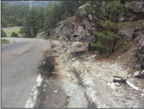
1.- Punto de impacto, en el Km. 258 + 900 de la Carretera No. 16 La Junta – Yepachi, tramo Tomochi – Límites del estado de Chihuahua, municipio de Guerrero, estado de Chihuahua.
