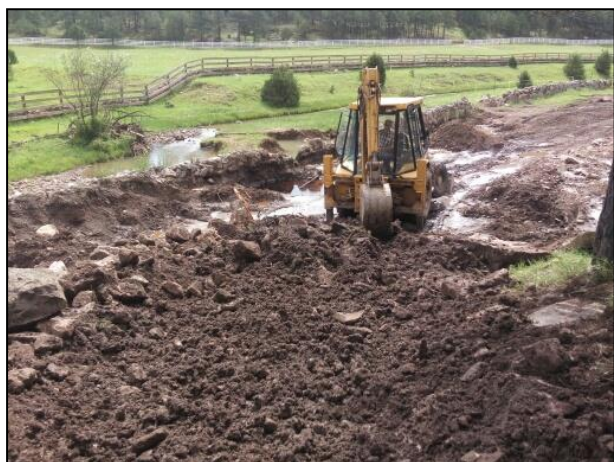
11.- Extracción de material afectado que se encontraba en el predio particular.
