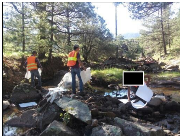
4.- Con apoyo de recurso humano se colocaron tapetes absorbentes en el arroyo "Pajaritos".
