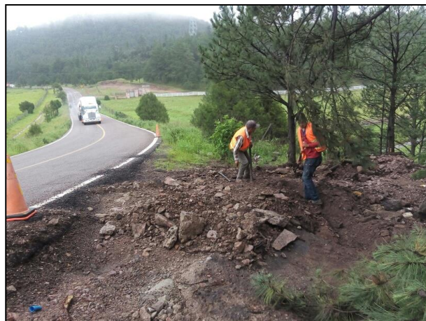
8.- Extracción de material afectado en derecho de vía con apoyo de recurso humano.
