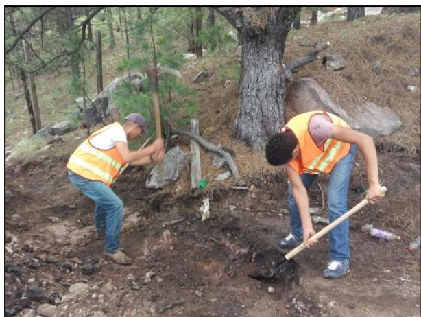
9.- Con apoyo de palas y picos se realizó la extracción a detalle del material afectado.
