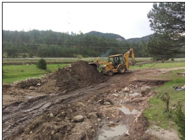
12.- Acarreo de material extraído con apoyo de retroexcavadora.
