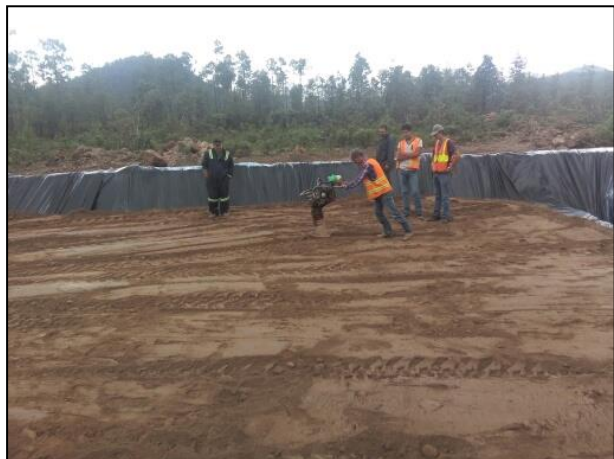
7.- Se realizó la compactación de la arcilla con apoyo de compactadora manual.
