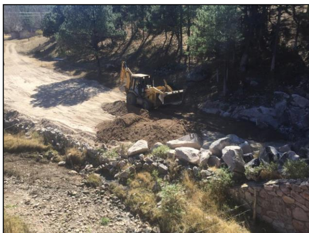
17.- Con apoyo de retroexcavadora se realizó el relleno correspondiente de las Fosas de Excavación.
