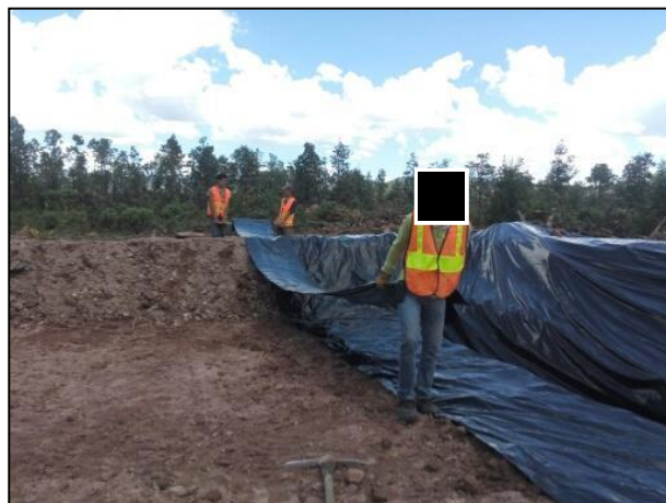
6.- Se cubrieron los bordos con película de polietileno de alta densidad.
