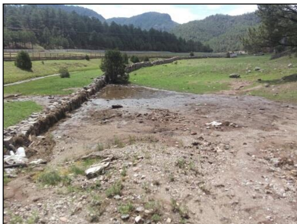
5.- En el sitio se observó un arroyo intermitente denominado “Pajaritos” mismo que el cauce de este resultó afectado .
