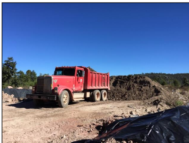
15.- Con apoyo de unidad de transporte se trasladó el material afectado a la celda provisional.
