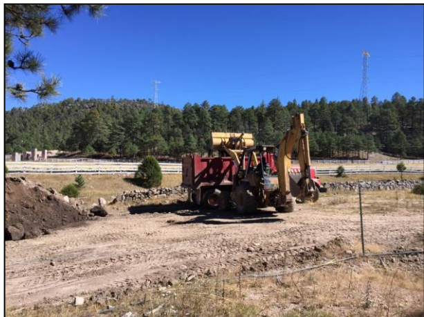
13.- Acarreo de material afectado a unidades de transporte con apoyo de maquinaria pesada.
