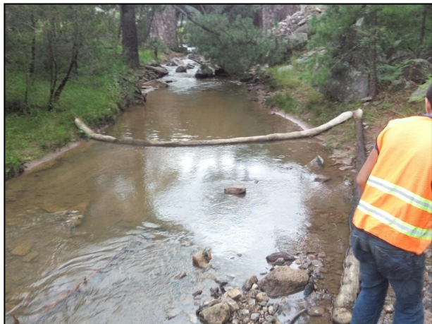
1.- Se colocaron cordones oleofílicos en el cauce afectado del arroyo intermitente denominado "Pajaritos".
