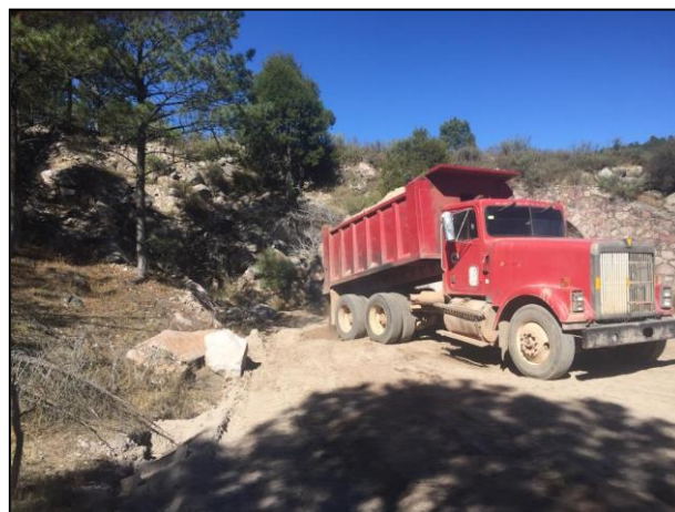
16.- Se realizó el relleno de las Fosas de Excavación.
