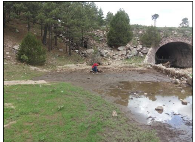
4.- Suelo natural afectado perteneciente a predio particular.
