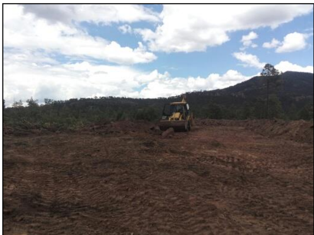
5.- Se realizó el acondicionamiento del sitio donde se construyó la celda provisional.
