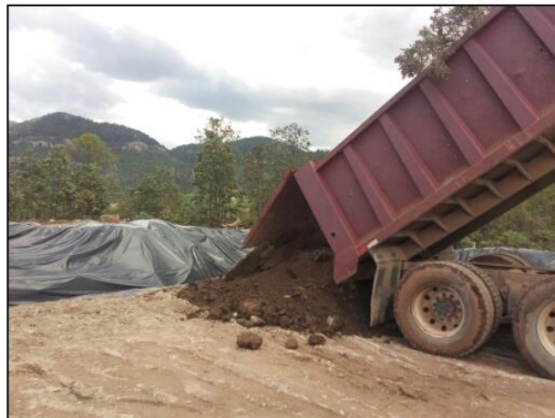
14.- Deposito de material afectado a celda provisional.
