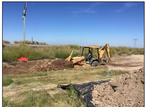
6.- Con ayuda de retroexcavadora se realizó la extracción del material edáfico afectado.
