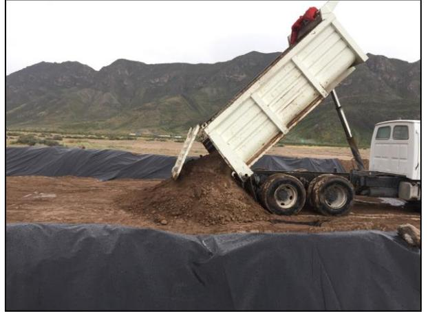
8.- Depósito del material edáfico afectado en la celda provisional.
