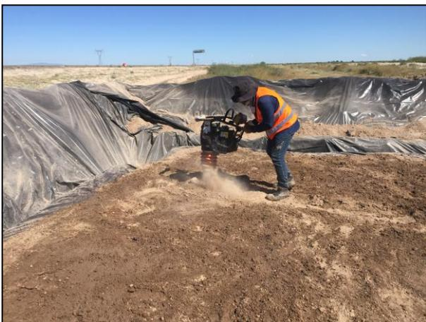
6.- Se colocó una capa de arcilla sobre la película de polietileno de alta densidad, para su posterior compactación.
