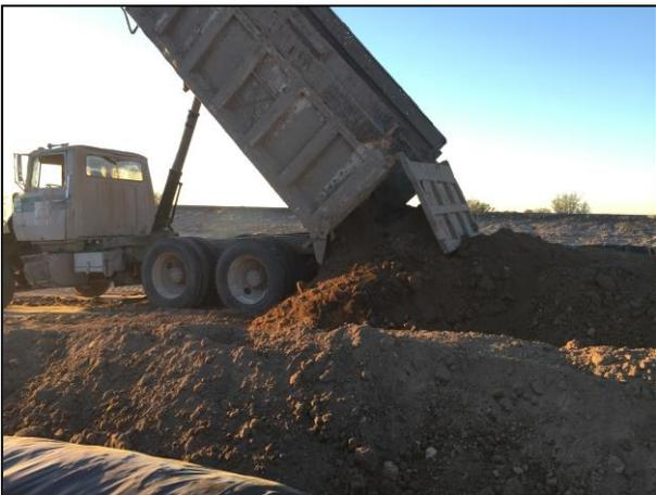
11.- Depósito de material edáfico afectado en celda provisional.
