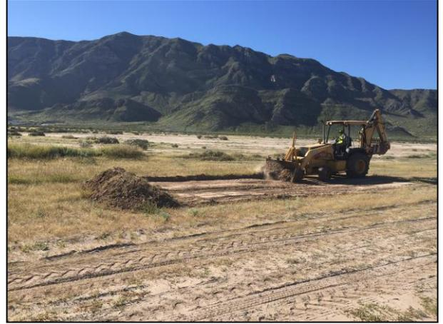
2.- Con apoyo de retroexcavadora se acondicionó el terreno para la construcción de la celda provisional.
