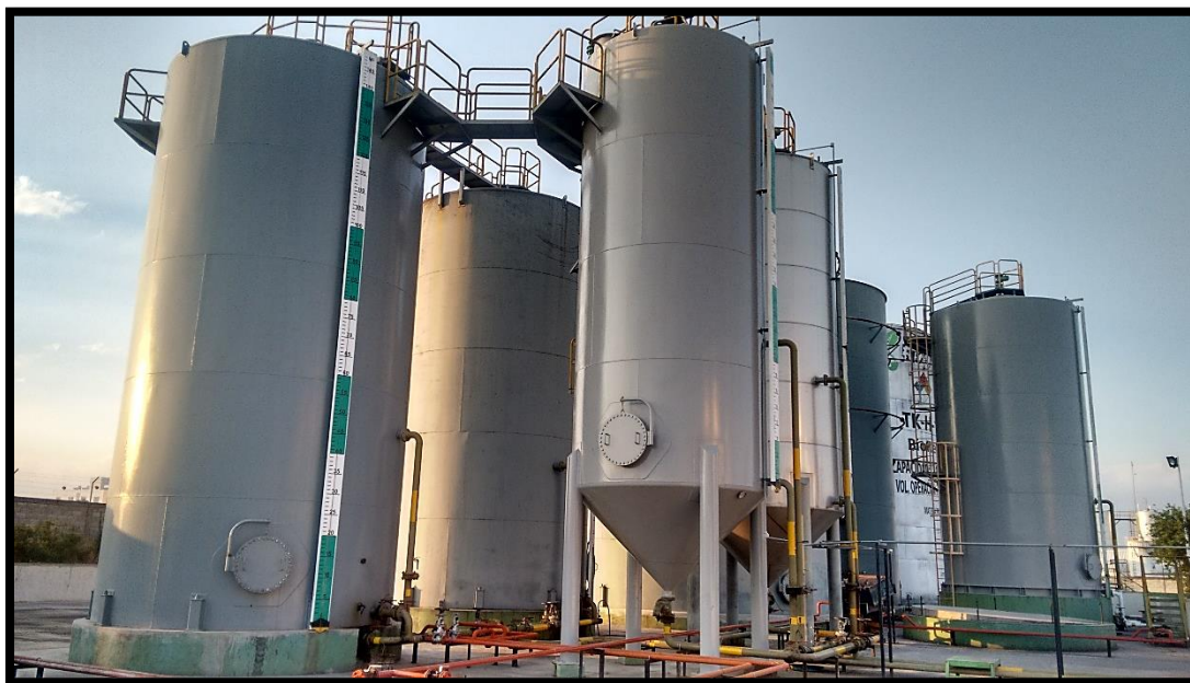
Ilustración 3. Fotografía del área de almacenamiento de materias primas.
