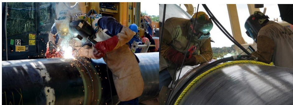
FIGURA 18. EJEMPLO DE ACTIVIDADES DE SOLDADURA DE TUBO DE ACERO.
