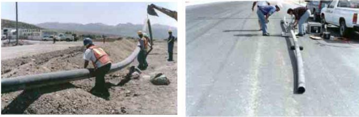
FIGURA 16. EJEMPLO DE ALINEADO DE TUBERÍA.
