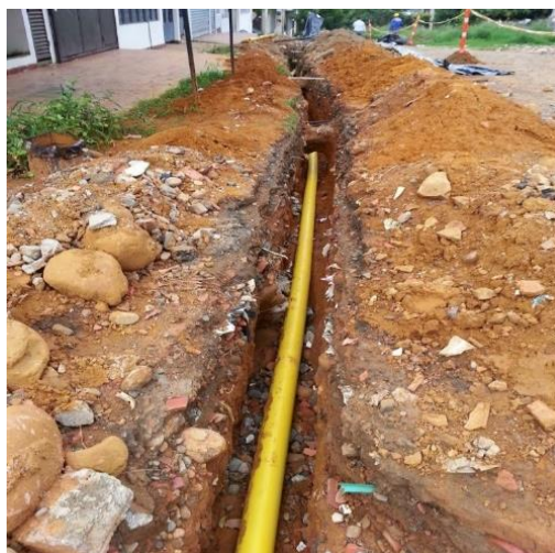
FIGURA 17. EJEMPLO DE TENDIDO DE LA TUBERÍA.
