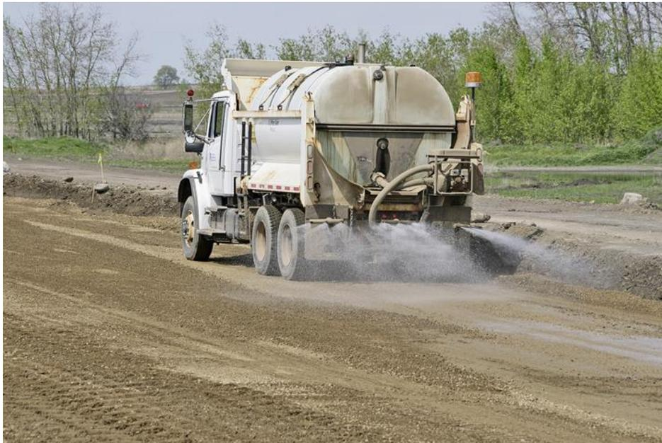
Figura VI.11. Ejemplo de pipa regando un camino para evitar dispersión de polvos (imagen obtenida de [heavyequipment.com](http://heavyequipment.com)).
