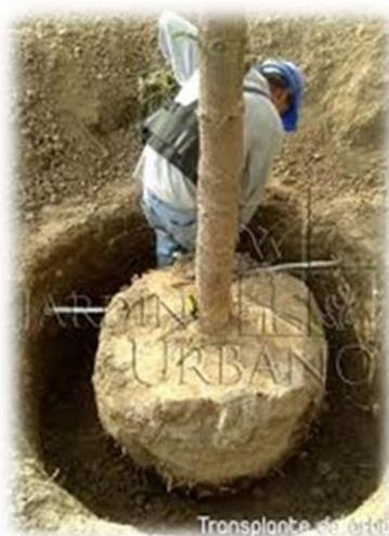
**Figura VI.14. Trasplante con cepellón<sup>2</sup>.**
