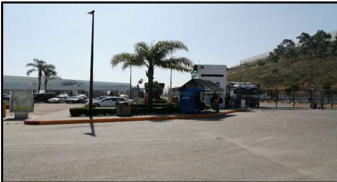
Foto 2. Instalaciones y estado actual del predio donde se ubicará la “Estación de Descompresión Bimbo”.
