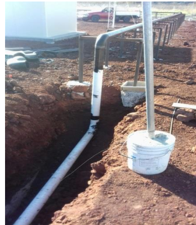
Ilustración 2-6 Ejemplo de Instalación de tuberías, así como de unión de tuberías
