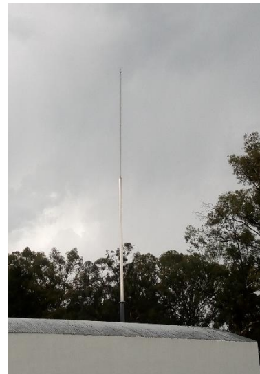
Ilustración 2-7 Ejemplo de Instalación del pararrayos y sistema de tierra físicas
