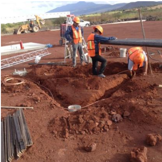
Ilustración 2-7 Ejemplo de Instalación del pararrayos y sistema de tierra físicas
