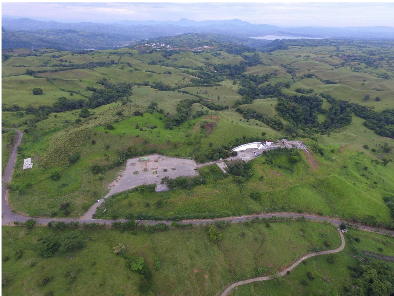
FIGURA III.4.4.2 VISTA AÉREA DE LA MACROPERA 1, POZO C-2, DONDE SE APRECIA LA AUSENCIA DE VEGETACIÓN EN LA ZONA EN LA QUE SE REALIZARÁN LAS ACTIVIDADES DE REPARACIÓN MAYOR CON REENTRADA.
