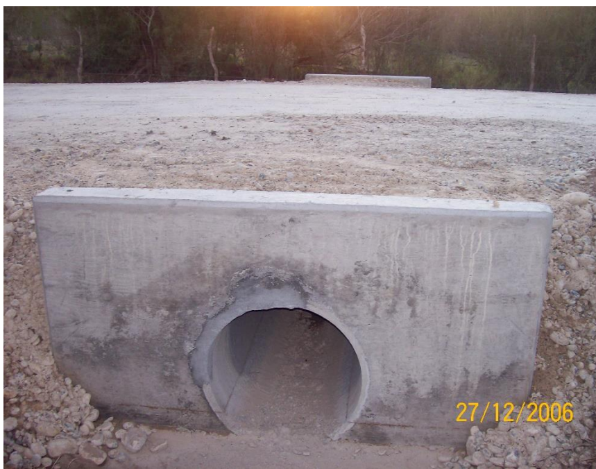
Fotografía III.4.4-3.- Ejemplo de alcantarilla sencilla en camino de acceso tipo, para evitar obstruir escurrimientos naturales instalación de alcantarilla de 30" de diámetro.-construcción de cabezotes fotografía tomada al término de la obra
