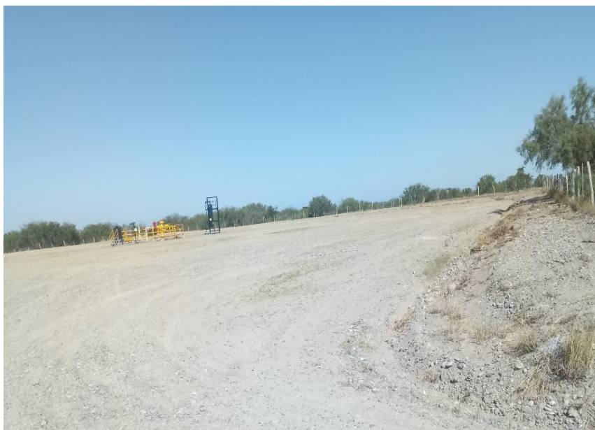
Fotografía I-2.- Macropera Calí 1 construida.
