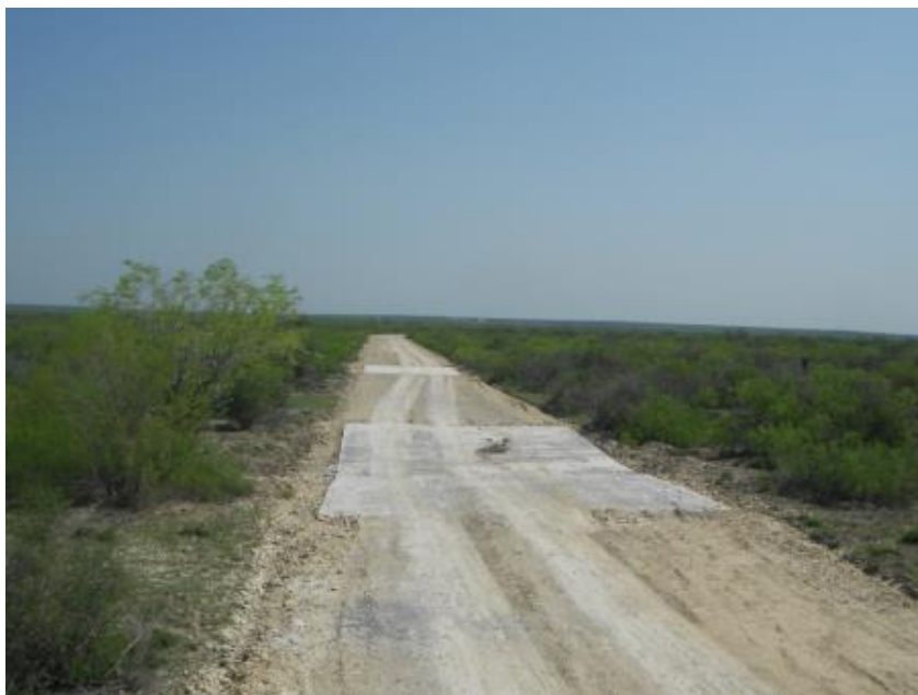
Fotografía III.4.4-2.- Ejemplo de obra especial vado tipo en camino de acceso para permitir el flujo natural del agua.
