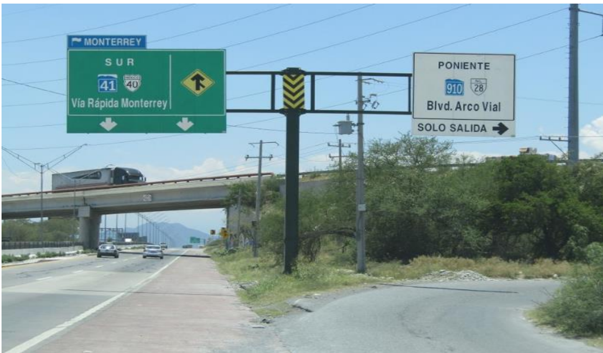
Ilustración 22. Cruce Puente elevado Arco Vial
