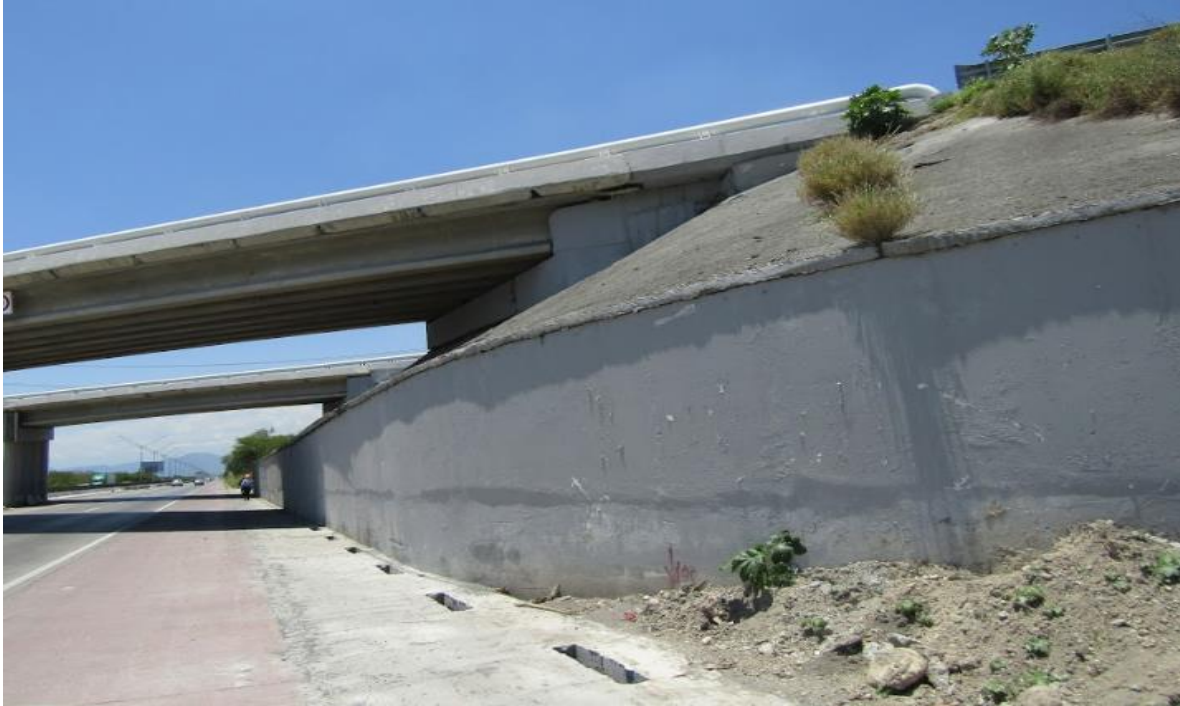
Ilustración 21 Cruce Puente Elevado Anillo Periférico sobre el área de proyecto
