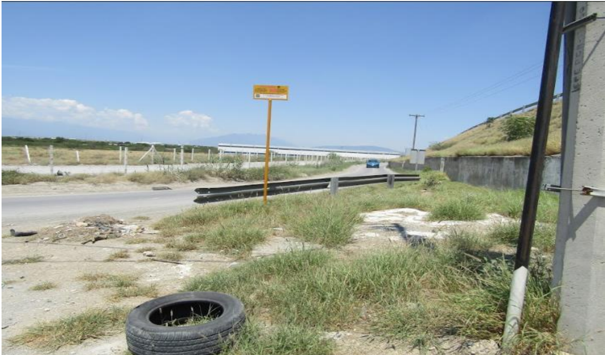
Ilustración 547. Caja de Interconexión ducto 12" Apodaca
