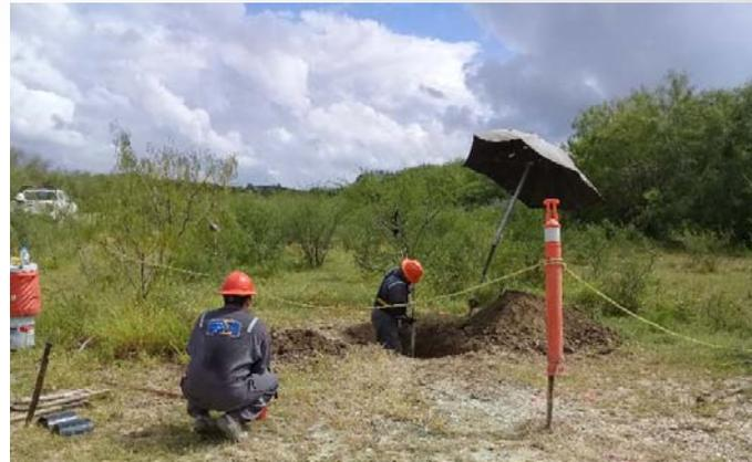
Excavación manual y con maquinaria para detectar fuga (26-07-2019)
