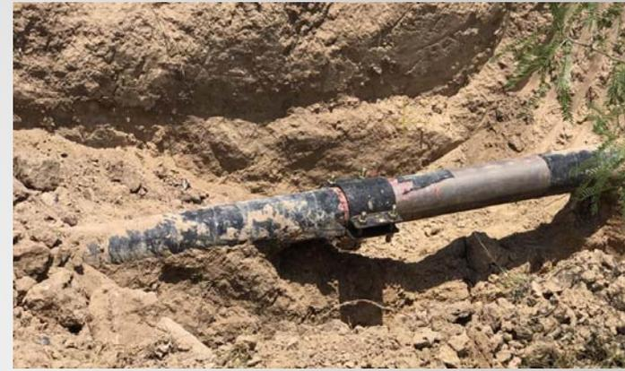
Excavación con maquinaria para detectar fuga y colocación de grapa
