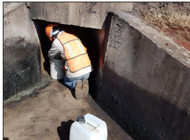
6.- Retiro de material afectado que se encontraba en el dren pluvial de concreto.
