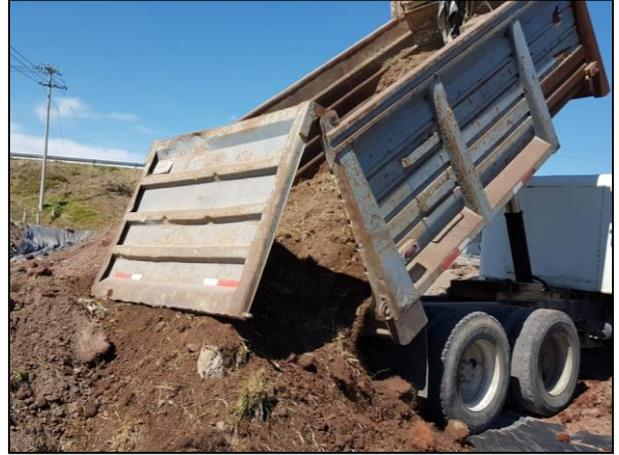
8.- Deposito de material edáfico afectado en celda provisional.
