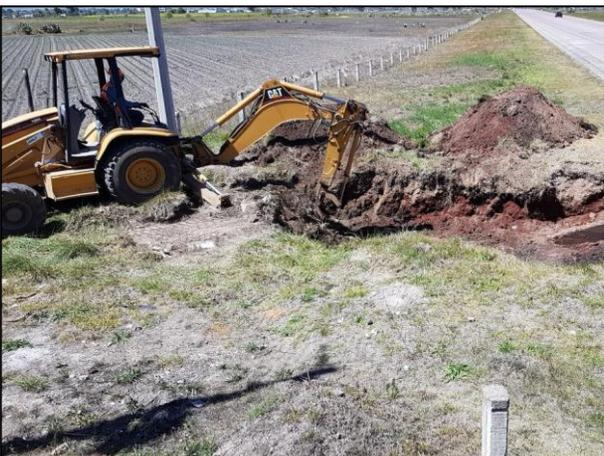
5.- Con apoyo de maquinaria pesada, se realizó la extracción de material edáfico afectado.
