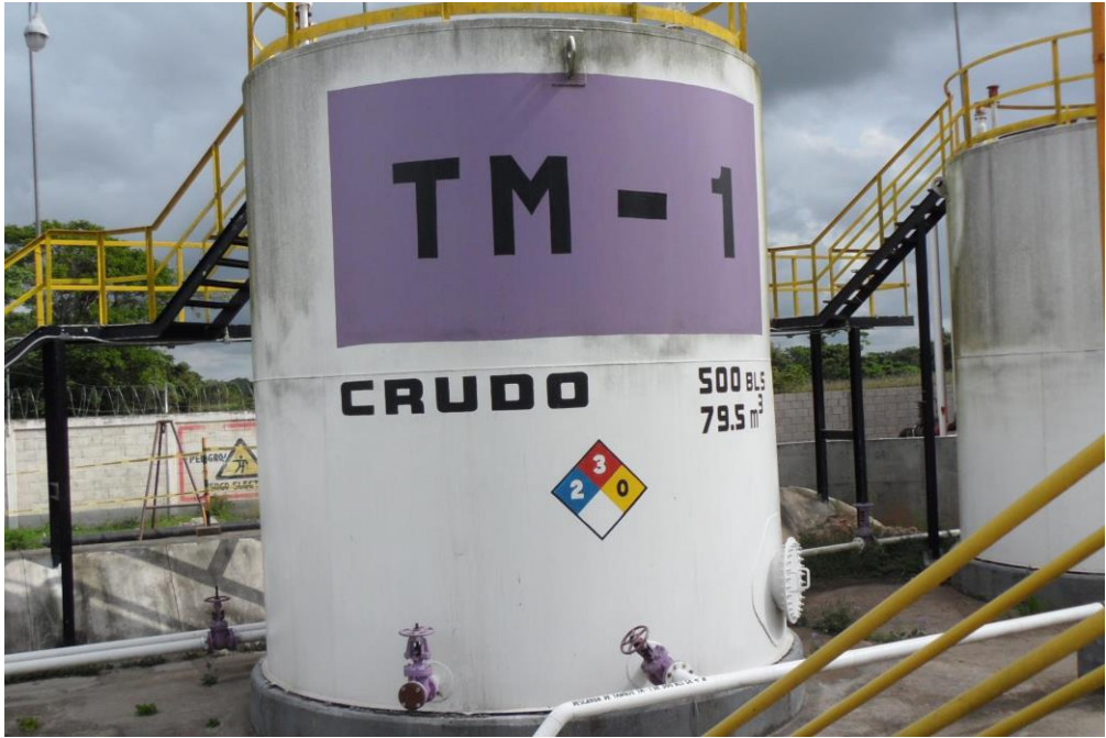
Figura 6.9-1 Dique de Contención en el Tanque de Almacenamiento TM-1.
