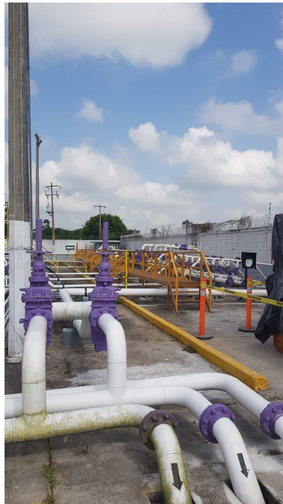
Cabezal de recolección primario.
