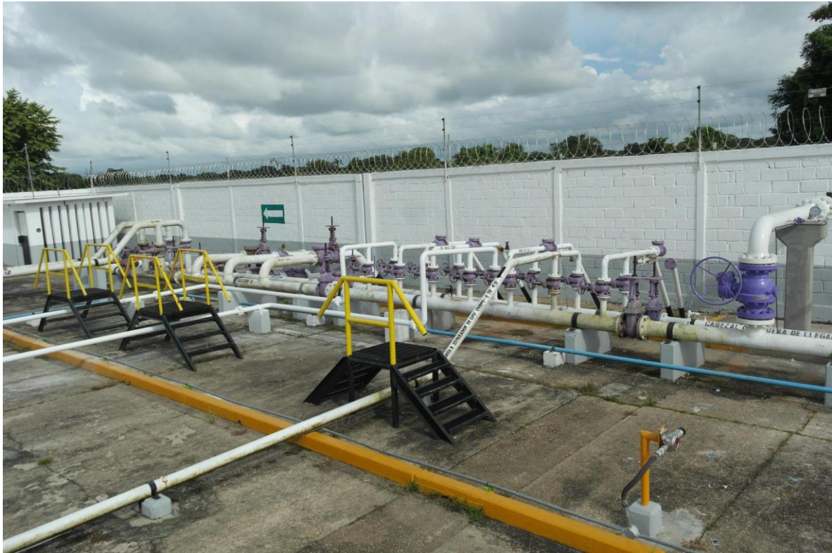
Figura 8.1-3 Cabezal de llegada Batería Ogarrío 2.
