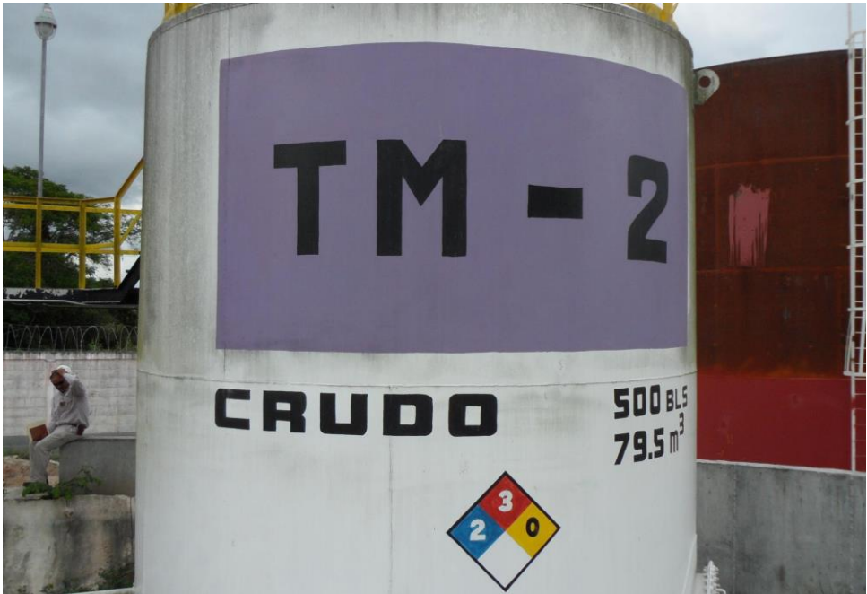
Figura 6.9-2 Dique de Contención en el Tanque de Almacenamiento TM-2.
