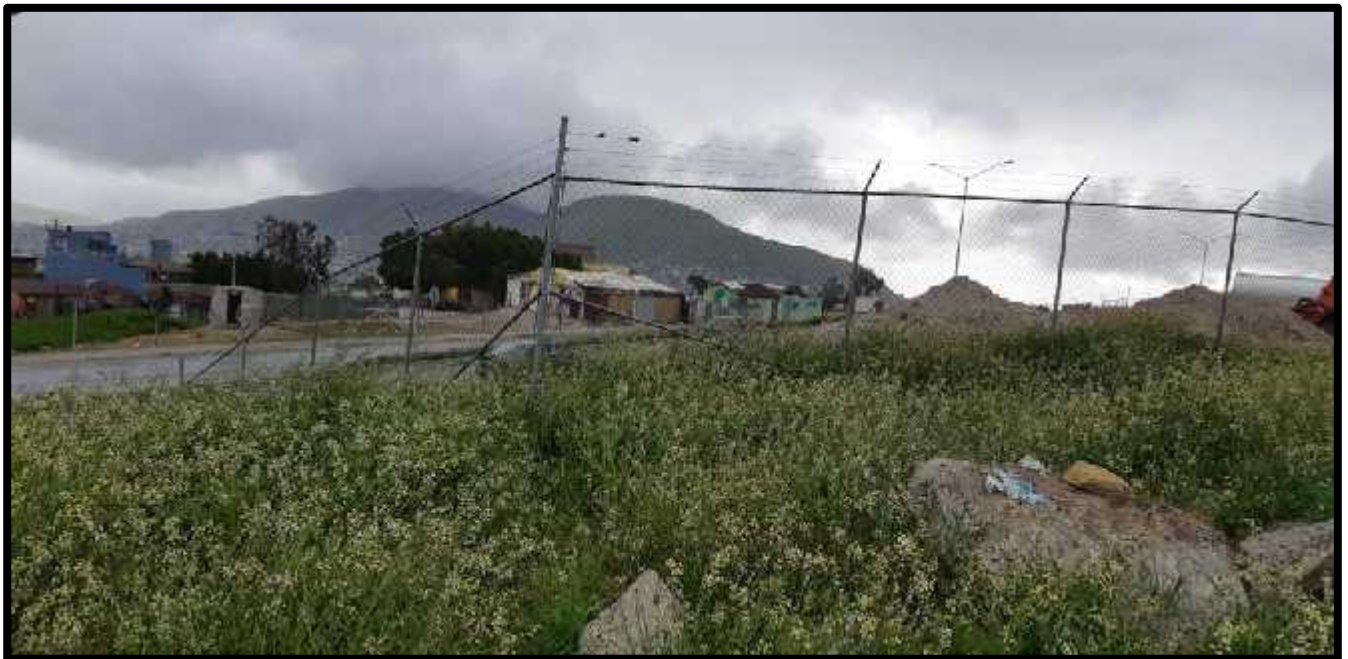
Foto 1. Vegetación dentro del Sistema Ambiental, aledaña al predio de la “Estación de Compresión Tijuana” (Vista Noreste - Suroeste).
