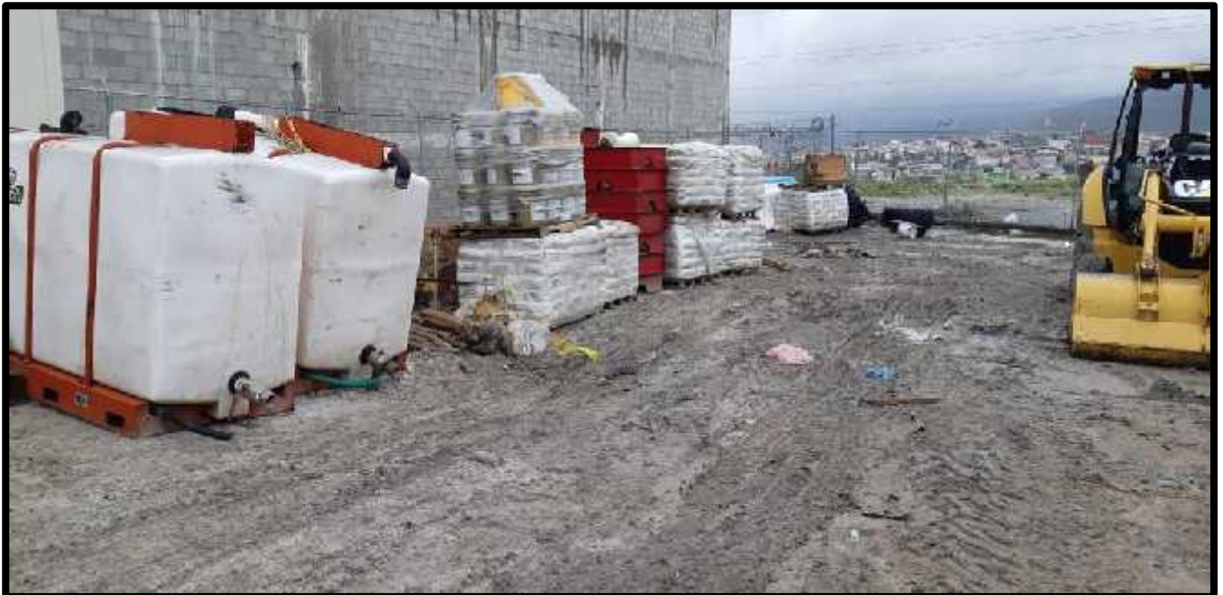
Foto 4. Instalaciones y estado actual del predio donde se ubicará la “Estación de Compresión Tijuana”.
