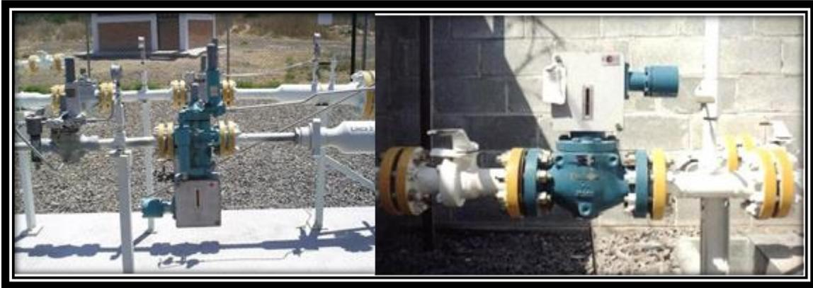
Ilustración 12 Válvula Slam Shut
