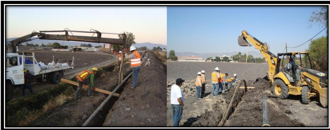
Ilustración 9 Alineado y tendido de ductos
