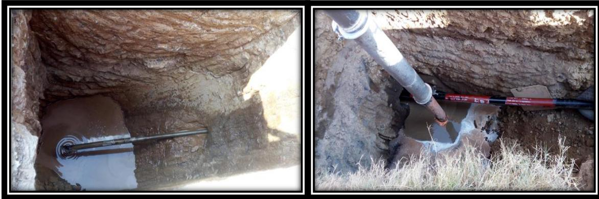
Ilustración 8 Perforación direccional y extracción de lodos de perforación
