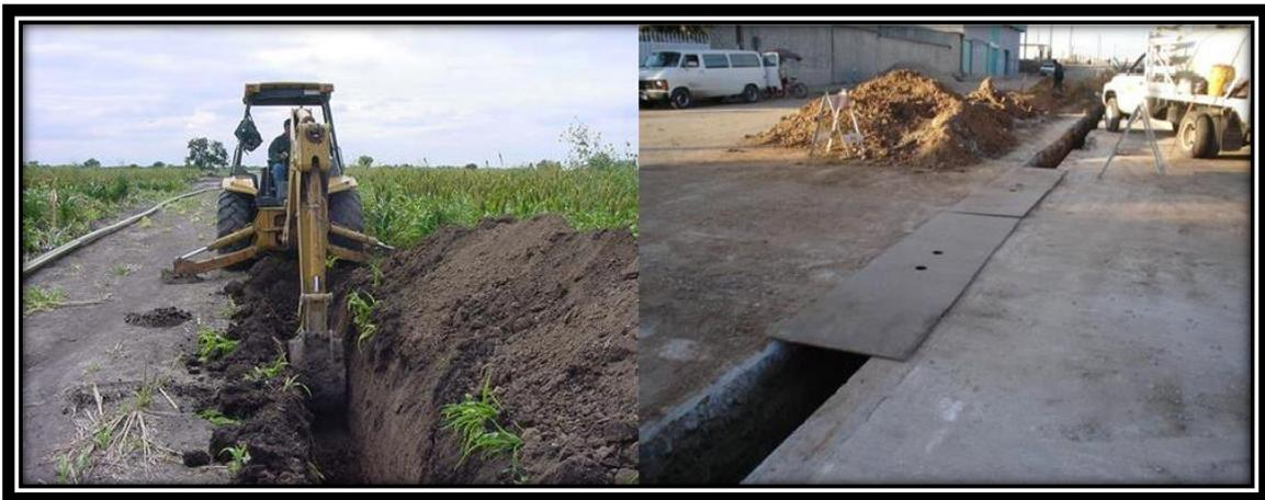
*Ilustración 7 Excavación de zanja e instalación de placas para paso de vehículos*
