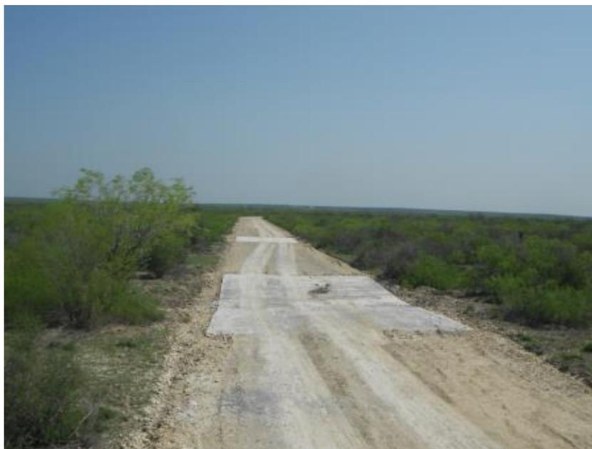
**Fotografía III.4.4-3.-** Ejemplo de obra especial vado tipo en camino de acceso para permitir el flujo natural del agua.
