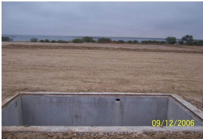
**Fotografía III.4.4-1.-** Ejemplo de contrapozo ubicado en la localización Arcabuz 448 para contención de derrames.
