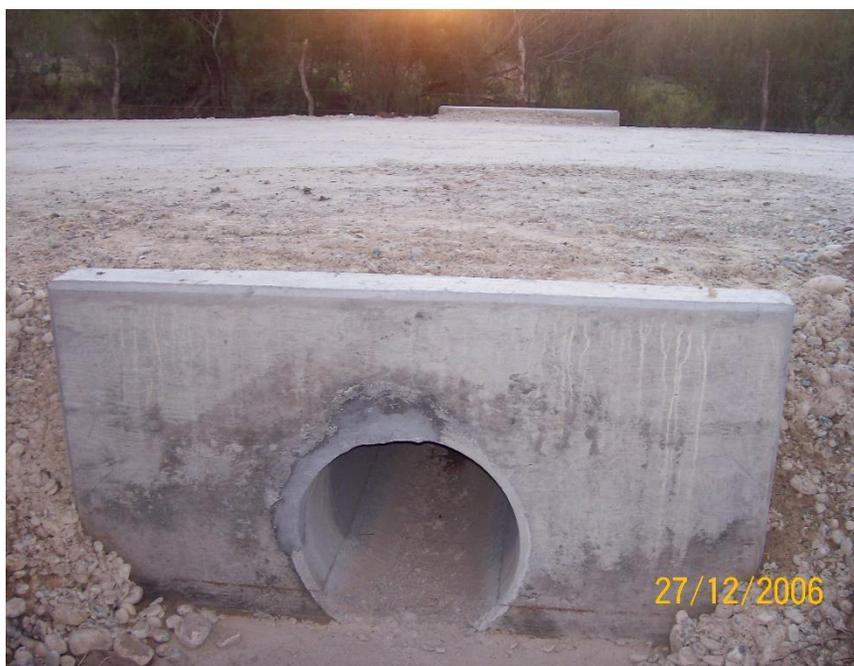
**Fotografía III.4.4-4.-** Ejemplo de alcantarilla sencilla en camino de acceso tipo, para evitar obstruir escurrimientos naturales instalación de alcantarilla de 30" de diámetro.-construcción de cabezotes fotografía tomada al término de la obra
