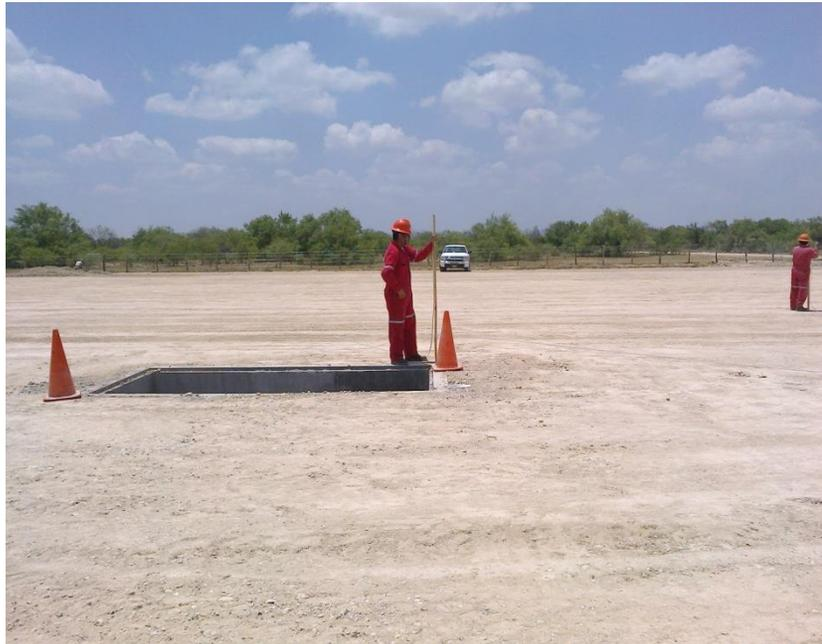
**Fotografía III.4.4-2.-** Ejemplo de contrapozo ubicado en la localización Arcabuz 448 para contención de derrames.
