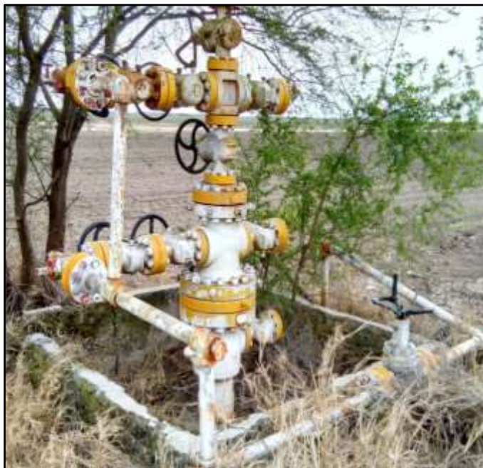
Figura 9. Superficie del Pozo Francisco Cano 47
