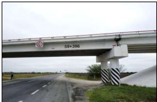
Figura 23. Camino de acceso al Pozo Francisco Cano 47
