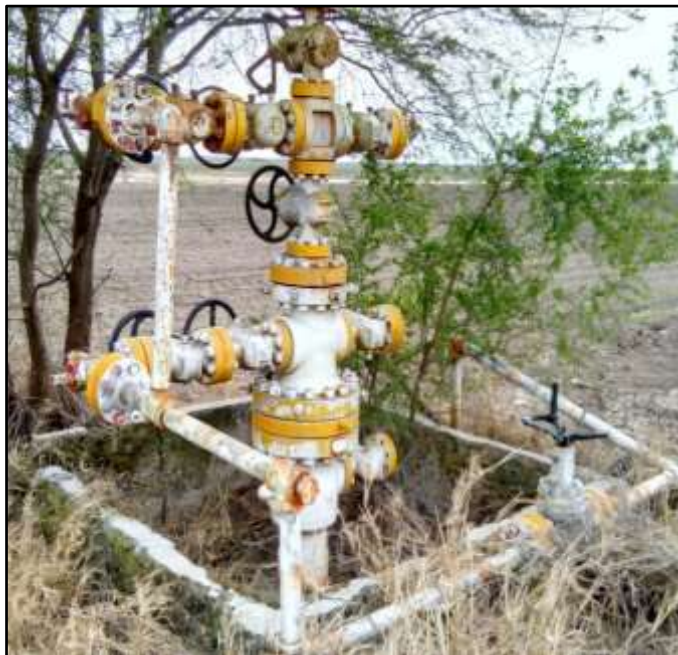
Figura 11. Mantenimiento a conexiones superficiales del Pozo Francisco Cano 47
