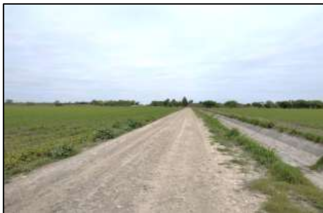
Figura 24. Camino de acceso al Pozo Francisco Cano 47
