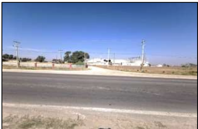
Figura 23. Camino de acceso al Pozo Francisco Cano 29
