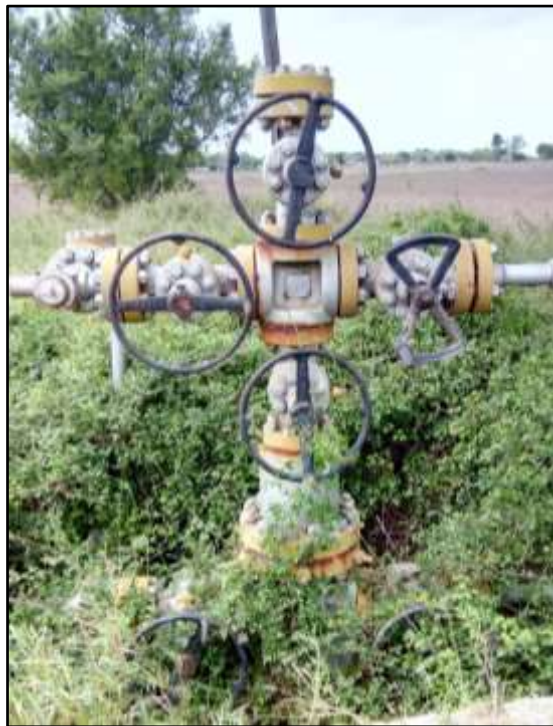
Figura 11. Mantenimiento a conexiones superficiales del Pozo Francisco Cano 29
